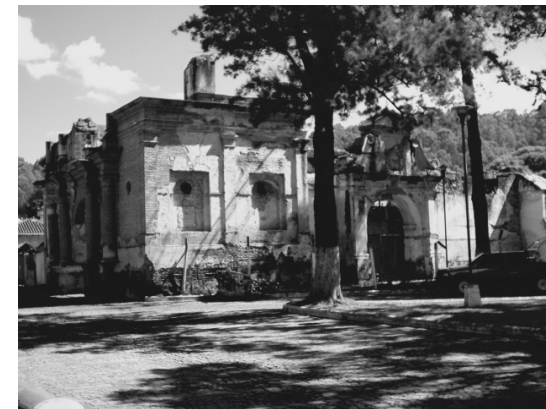
FOTO NO. 13 San Sebastián (exterior)
