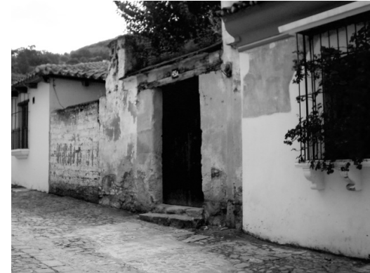
FOTO NO. 34: Ingreso al Monumento
