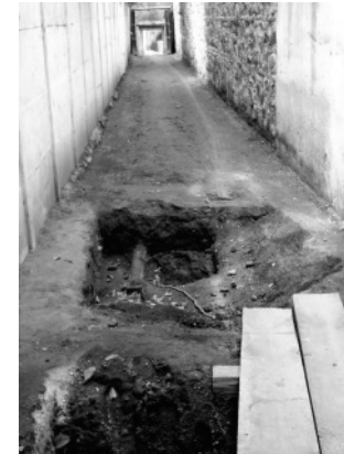
FOTO NO. 35: Servidumbre de Paso, trabajos de drenajes
