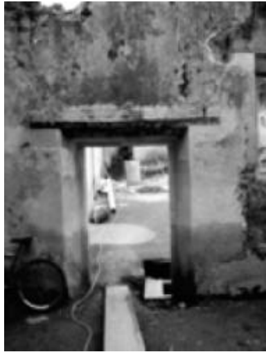
FOTO NO. 36: Ingreso al Convento
