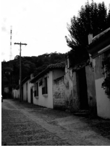
FOTO NO. 32: Infraestructura eléctrica
