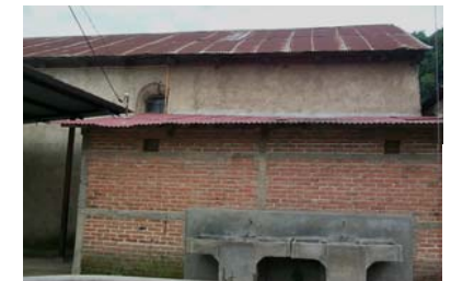
Fotografía No. 14 Vista de las pilas públicas que existen actualmente las cuales son de cemento.
