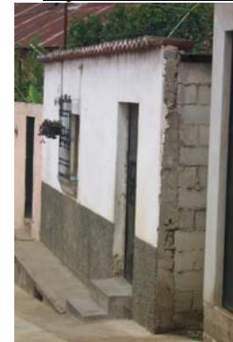
Fotografía No. 11 Vivienda de block y lámina de zinc se puede observar que ya se pavimento la calle en el Año 2,003.
