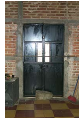
Fotografía No.36 Vista interior de puerta de la sacristía del templo.
