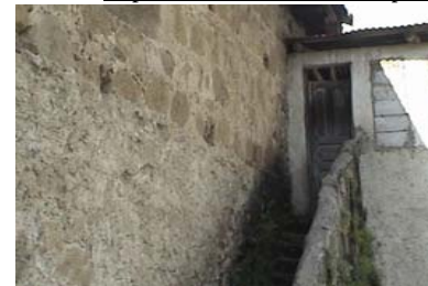
Fotografía No.34: Vista de Gradas de acceso hacia el Campanario.
