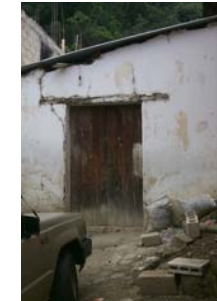
Fotografía No. 57 Vista de puerta de entrada y salida a bodega.
