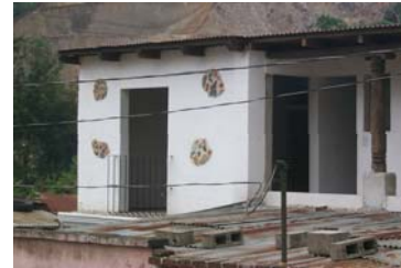
Fotografía No. 23 Vista de Fachada de segundo nivel en construcción del año 2,002.
