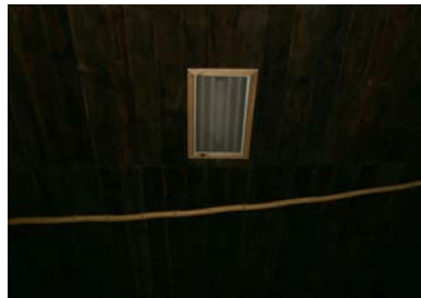
Fotografía No.38 Vista interior del techo del templo San Luis Las Carretas.
