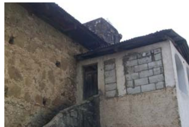
Fotografía No.33 Vista de Campanario de la fachada Sur-Este del Templo.
