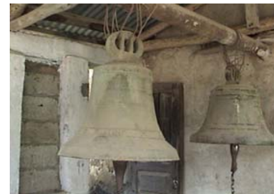
Fotografía No. 52 Vista de las campanas existentes.
