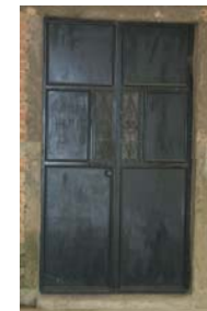
Fotografía No. 58 Vista De puerta de ingreso Y salida al exterior de de la sacristía.
