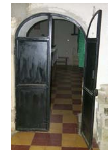
Fotografía No. 59 Vista de puerta de entrada y salida a la sacristía.
