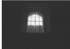
Fotografía No 61 Vista interior de ventana de del templo.
