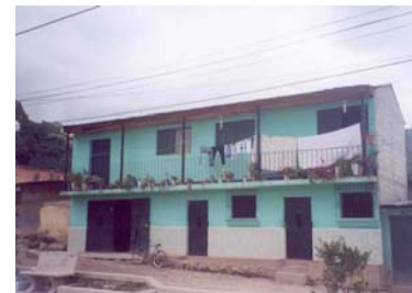
Fotografía No.7: Vivienda De dos niveles de block y Mixto losa.
