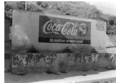
Fotografía No. 13 Tomada en 1989 se observan las pilas son de adobe y se encontraban en mal estado por lo que se reemplazaron.
