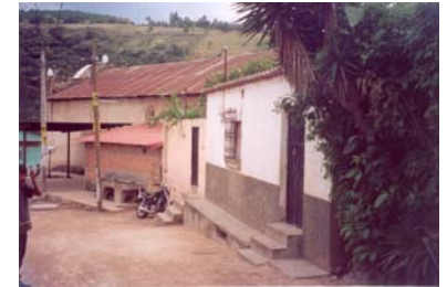
Fotografía No. 12: Podemos observar que la vivienda es de block y lámina de zinc y la calle aun no se había pavimentada en el año 2,002.
