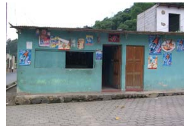
Fotografía No.25 Vivienda comercio de adobe y lámina de zinc.
