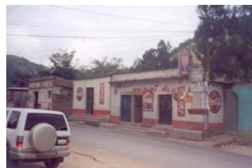
Fotografía No.16 Vista de fachadas al Sur del Templo San Luis Las Carretas.
