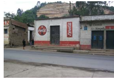
Fotografía No.17 Fachada a un costado del Salón Municipal al lado izquierdo es de adobe y lámina de zinc.
