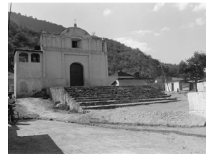
Fotografía No.30 tomada después del terremoto de 1,976 se observa el muro de adobe que existe sobre la fachada Frontal del templo
