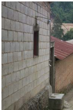
Fotografía No. 9 Fachada de block y lámina de zinc ubicada al Nor-Este del templo San Luis Las Carretas.
