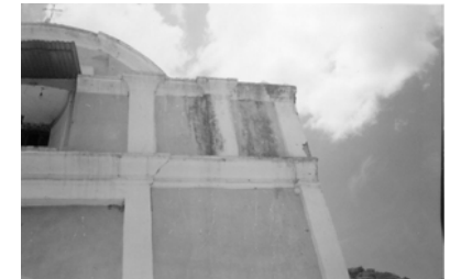
Fotografía No. 66 Vista de esquina superior dañada por humedad
