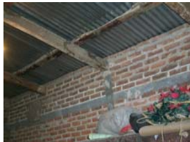
Fotografía No. 54 Vista de la estructura del techo de la sacristía.
