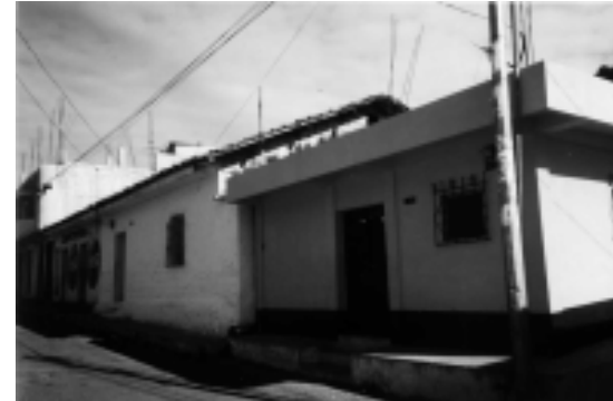
FOTOGRAFIA No 10 vista sur-norte , de la 4ta calle entre 2da y primera avenida
