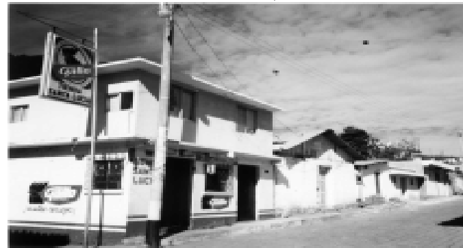
FOTOGRAFIA No 6 vista sur-norte, 3era. Calle entre 1 y 2 avenida.
