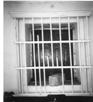
FOTOGRAFIA No 3 Deterioro: Balcon de madera.
