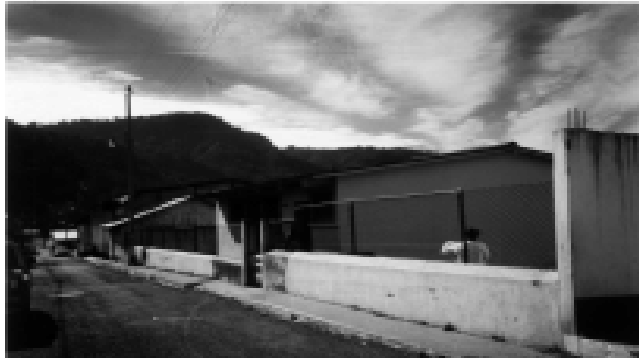
FOTOGRAFIA No 2 vista norte sur, 4 calle entre 1 y 2 avenida.
