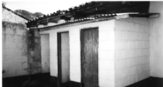
FOTOGRAFIA No 12, alteración block y lámina,
