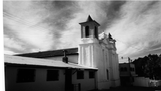
FOTOGRAFIA No 4 vista occidente-oriente, de la 1 avenida
