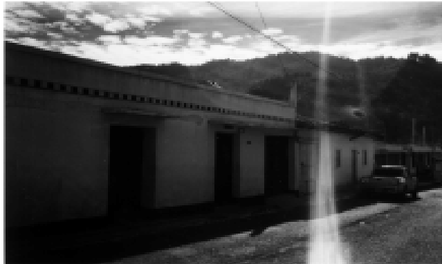
FOTOGRAFIA No 3 vista norte-sur, 4 calle entre 1 y 2 avenida .
