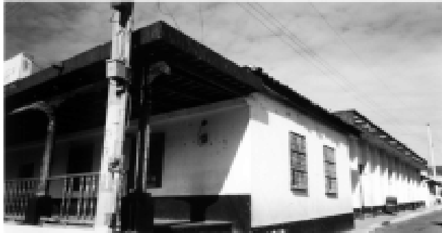
FOTOGRAFIA No 1 vista sur-norte, 4 calle entre 1 y 2 avenida.
