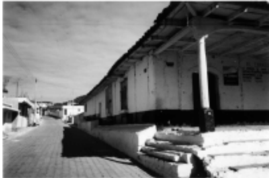
FOTOGRAFIA No 8 vista sur-norte, 3era. Calle entre 1 y 2 avenida
