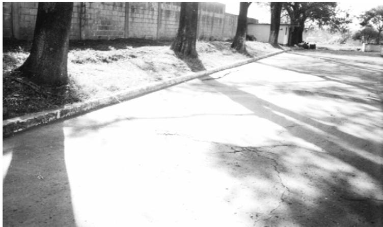
FOTOGRAFÍA 14: LA BARRERA NATURAL DE ÁRBOLES GRANDES, COLOCADA A 50 CM. DE LA CALLE A LEVANTADO CON SU RAÍZ, LA CAPA ASFÁLTICA PRODUCIENDO GRIETAS Y FRACTURA DEL PAVIMENTO.
