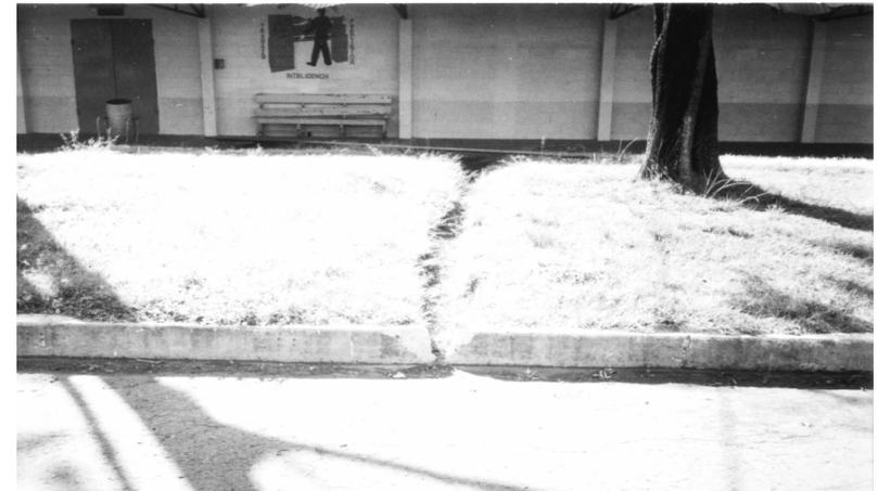
**FOTOGRAFIA 38:** CANAL A FLOR DE TIERRA, CONSISTENTE EN UNA ZANJA DE 25 CM. DE ANCHO POR 15 CM. DE PROFUNDIDAD.
