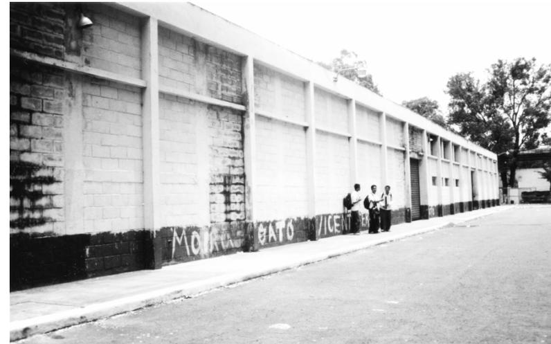
FOTOGRAFÍA 6: VISTA OESTE. LOS ANGARES NO CUENTAN CON VENTILACIÓN NATURAL Y ARTIFICIAL ADECUADA MANTENIENDO UN AMBIENTE INSALUBRE EN EL INTERIOR.
