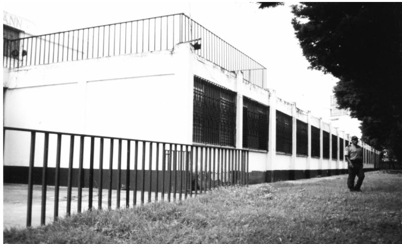
FOTOGRAFÍA 7: EL TAMAÑO Y LA POSICIÓN DE LA VENTANEARÍA DEL EDIFICIO DE AULAS ES INADECUADO, SU ÚNICA ORIENTACIÓN ES SUR, PRODUCIENDO AMBIENTES DEMASIADO CÁLIDOS.
