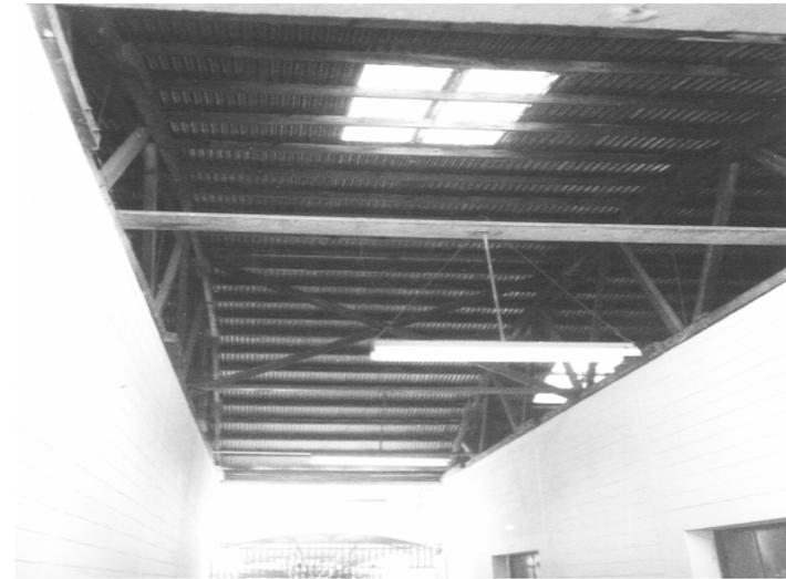
FOTOGRAFIA 34: EL SISTEMA DE CANALES DE LA CUBIERTA COLAPSO, PROVOCANDO CONTAMINACIÓN POR HUMEDAD EN ALGUNAS PARTES DE LA ESTRUCTURA, CERCANAS A LOS APOYOS.
