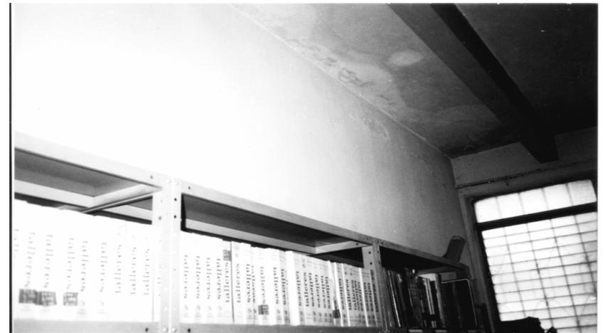
FOTOGRAFÍA 9: LOS TECHOS PLANOS EN EL EDIFICIO ADMINISTRATIVO TIENEN GRIETAS QUE FILTRAN AGUA DE LLUVIA, DESPRENDIENDO EL ACABADO INTERIOR DEL TECHO.
