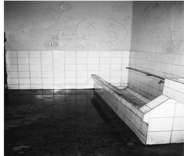
**FOTOGRAFIA 44: EL PISO SE VE CUBIERTO POR EL AGUA DE LOS SANITARIOS, LA QUE SE DERRAMA DEBIDO AL PÉSIMO ESTADO DE LA RED, ARTEFACTOS Y ACCESORIOS.**
