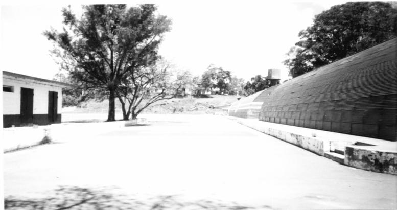
FOTOGRAFÍA 11: LA BASE DE LAS PAREDES EN LOS TALLERES TIPO IGLÚ, SE HA CORROÍDO, FILTRANDO AGUA DE LLUVIA EN ÉPOCA DE INVIERNO.
