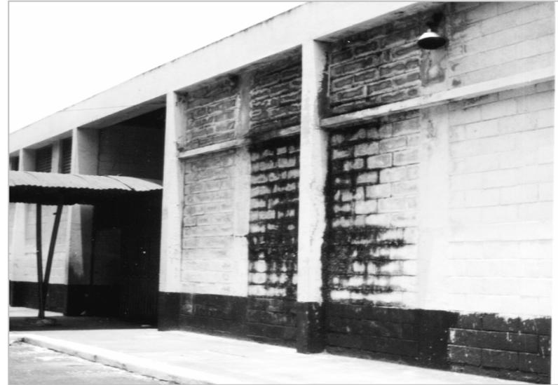
FOTOGRAFÍA 5: COLAPSO DEL SISTEMA DE CANALES DE TECHO EVIDENCIANDO HUMEDAD Y CONTAMINACIÓN POR HONGO EN LOS MUROS.
