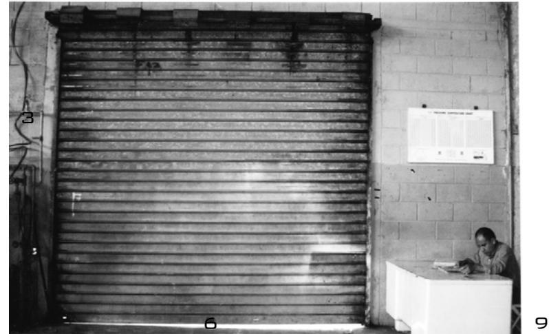
FOTOGRAFÍA 16: MUESTRA EL ESTADO DE DETERIORO DE LAS SALIDAS DE EMERGENCIA, LAS QUE UTILIZAN UN SISTEMA DE PUERTA TIPO PERSIANA ENROLLABLE, QUE SE OPERA MANUALMENTE SIN GARANTIZAR SU FUNCIONAMIENTO.
