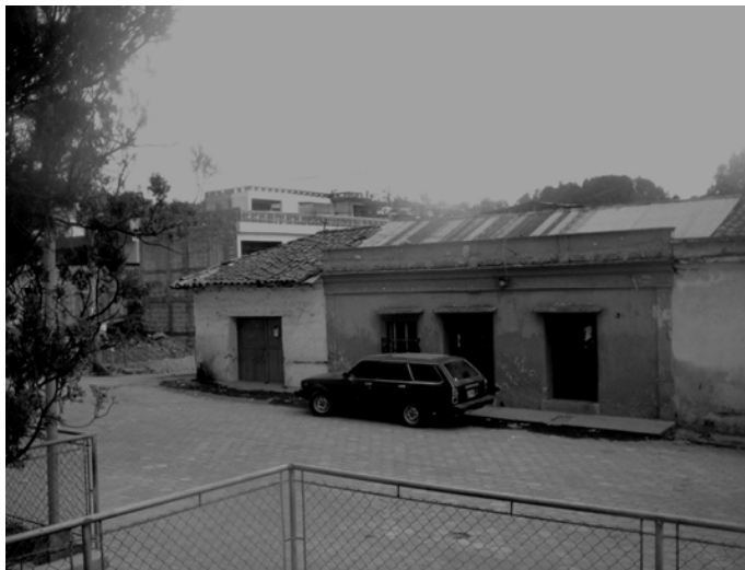
Vivienda destruida al fondo.
