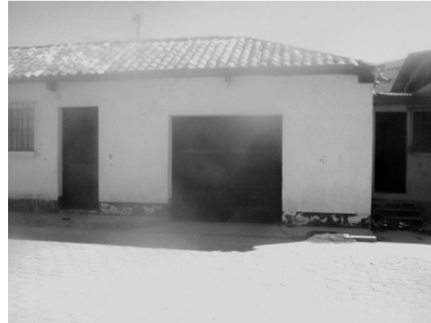
Casa San Francisco, anexo a la casa parroquial, muros de block, y cubierta de lámina de zinc y tejas sobrepuertas. Las puertas son de metal, de color negro mate y las ventanas son horizontales.
