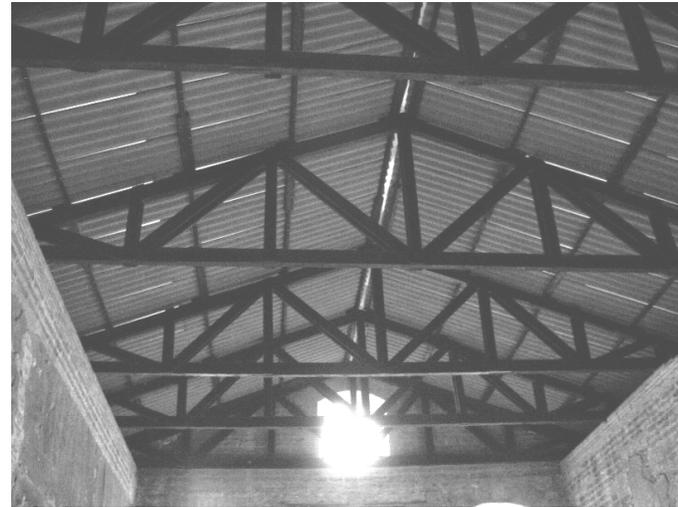
**F6-** Integración de estructura metálica y cubierta de lámina.
