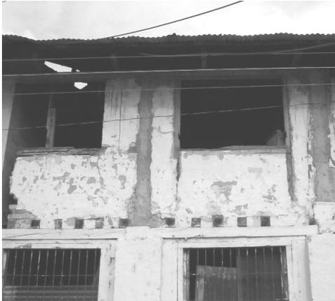
Saneamiento de pared con cemento visto (alteración) y desprendimiento de repello.
