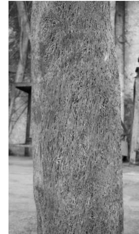
Shut empleado como columna para sostener una cubierta de lámina.
