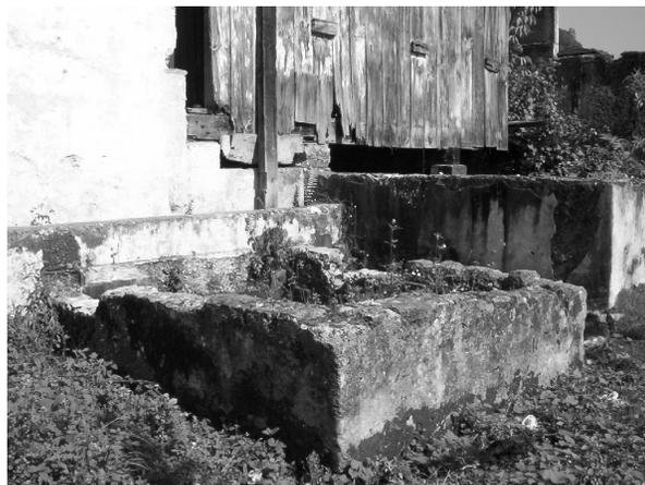
**F29** – Se puede apreciar la pila de dimensiones pequeñas donde depositaban el café que flotaba en el correteo.
