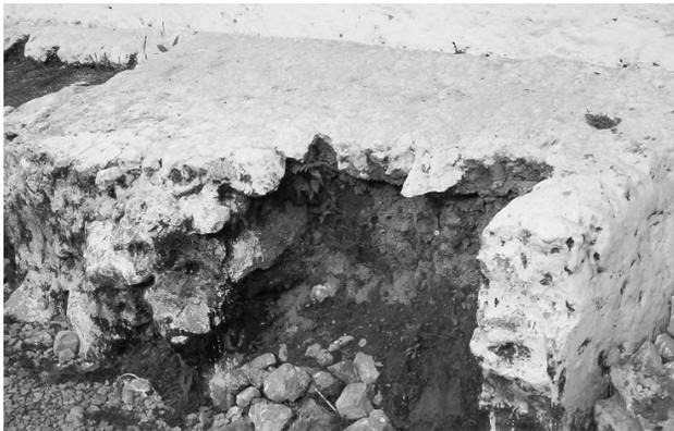
Desmoronamiento de contrafuerte en fachada frontal (daño).
