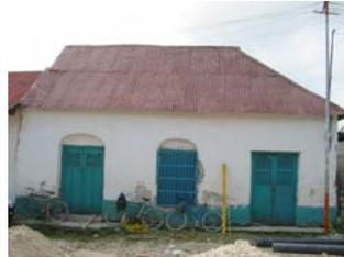
**FOTO No.1:** Se observa que las edificaciones siguen conservando de sus primeras construcciones, el tipo de acabado de sus paredes, siendo alisado de una mezcla de tierra con cal.
