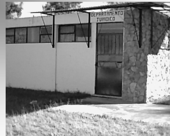
Foto 6: El Hospital cuenta con el departamento legal. Puede observarse el acceso al edificio.
