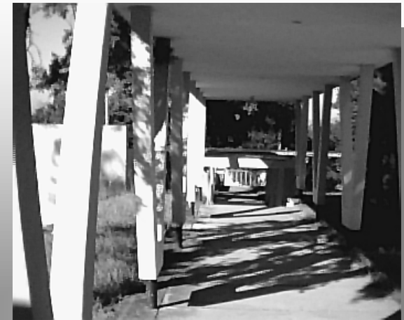
Foto 5: Corredor entre edificios, puede observarse la Protección solar y de lluvia entre edificios.
