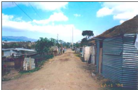
FOTO 20: asentamiento Comunidad La Paz perteneciente al municipio de San Miguel Petapa, (Fotografía f1).
