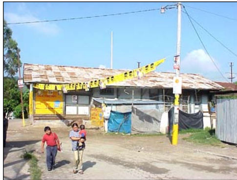
Foto 2: estación de Moran en Villa Canales en total deterioro por el abandono de FEGUA.
