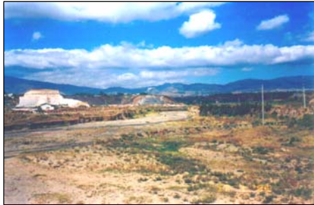
FOTO 19: continuación del tramo ferroviario a orillas del río Villalobos, junto al posteo eléctrico, (Fotografía e2).
