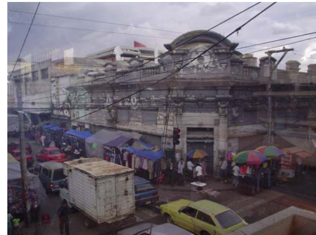
Fotografía No. 2 Edificio PRIMERA SEDE DIARIO DE CENTRO AMÉRICA, sujeto a los factores expuestos anteriormente.
