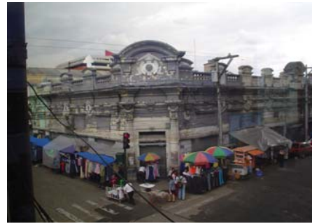
Edificio Primera Sede Diario de Centro América
