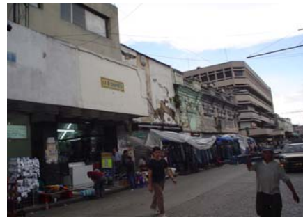
6ª. Av. sur entre 10ª. Y 11. calles poniente
