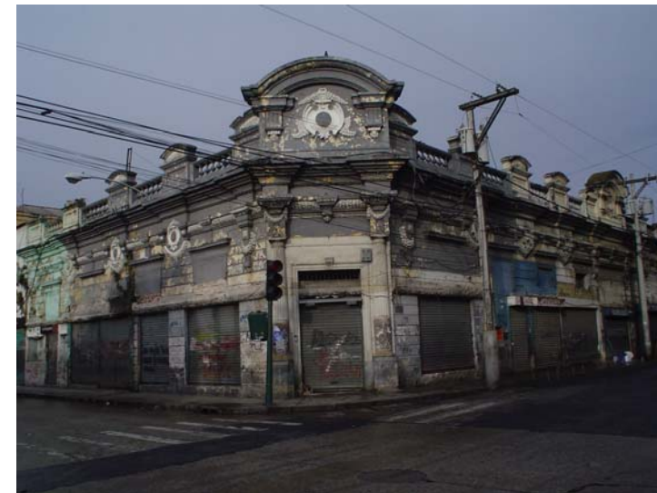
FOTOGRAFÍA No. 1 EDIFICIO PRIMERA SEDE DEL DIARIO DE CENTRO AMÉRICA
