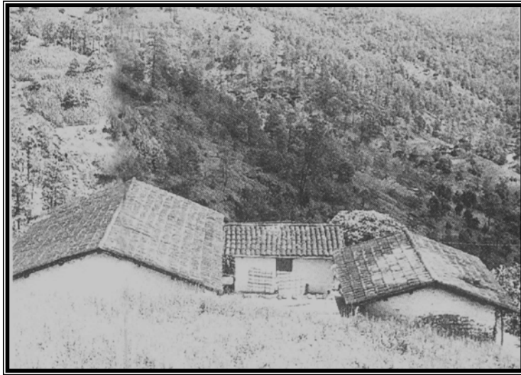
-FOTO No. 3- CONSTRUCCIONES DE LAS VIVIENDAS EN EL MUNICIPIO
