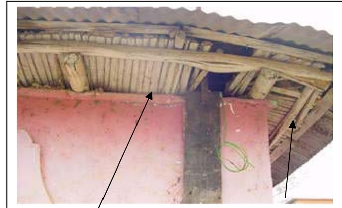
Solera cubierta con palos y tierra con cal.
