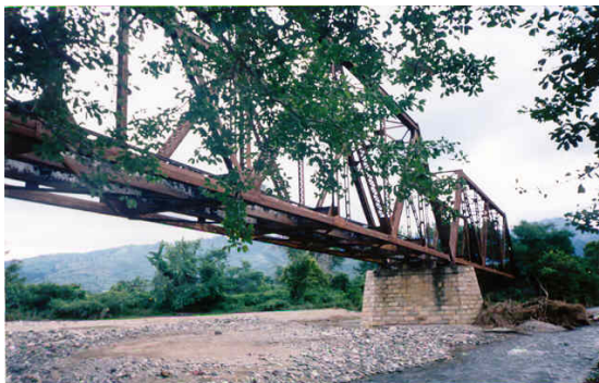
Foto No. 22 El puente ferroviario sobre el Río San José, donde se aprecia las buenas condiciones de su estructura portante. Fuente: José Manuel Sanabria. Febrero 2004.
