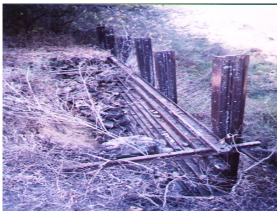
Foto. No. 36 Trinchera hecha con rieles del ferrocarril, que ha quedado expuesta, a consecuencia de los deslaves producidos por la lluvia. Fuente: José Manuel Sanabria. Año 2004.
