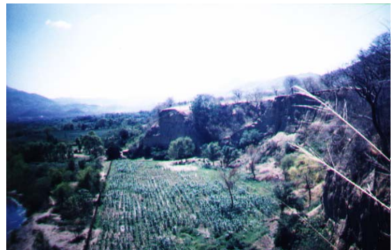
Foto No. 20 Desaparición de la plataforma ferroviaria, debido a la erosión causada por el Río San José. Hoy ocupado por agricultores. Fuente: José Manuel Sanabria. Febrero 2004.
