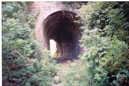
Foto. No. 39 El Túnel No. 11, cerca de la Estación El Rincón, donde se aprecia la vegetación, y los soterramientos de la vía. Fuente: José Manuel Sanabria. Noviembre 2003.
