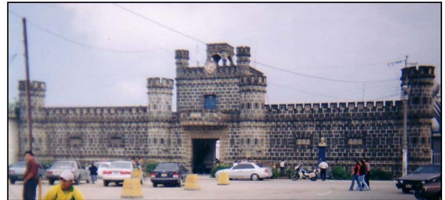
Edificio de la Policía nacional de Chimaltenango (Fuente, propia)
