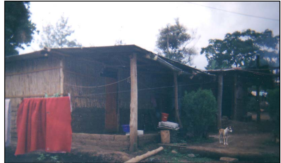
Viviendas tradicionales después del terremoto, (zócalo de adobe, paredes y techos de material liviano) (Fuente, propia)
