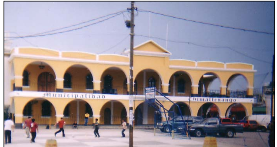
Municipalidad de Chimaltenango Su remodelación concluyó en diciembre de 1,999. 23 (Foto: fuente propia)
