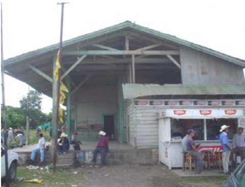
Foto 32. Estado actual del edificio de la Estación en Ipala, ala Norte fuente: Silvia Rosales, Octubre 2003.
