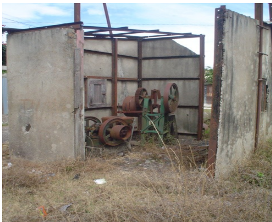
Foto 45. Casa Bomba de Agua, Estación Ipala. Fuente: Silvia Rosales, Octubre 2003.
