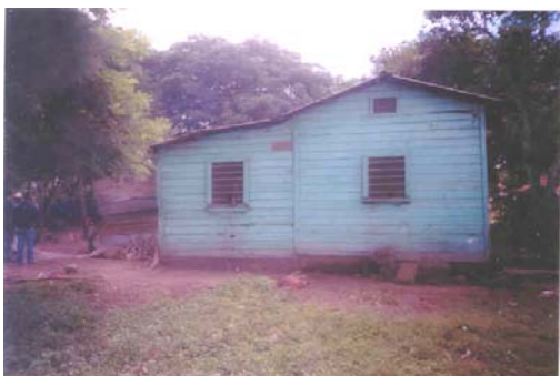
Foto 37. Fachada Norte. Casa del Agente, Estación Ipala Fuente: César Mota, Octubre 2003.
