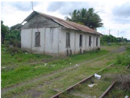
Foto 42. Taller de Mantenimiento, Estación Ipala. Fuente: Silvia Rosales, Octubre 2003.
