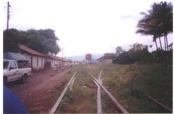
Foto 23. Vista Perspectivada de la Estación Ipala, hacia el Norte. Fuente: Silvia Rosales, febrero 2004.
