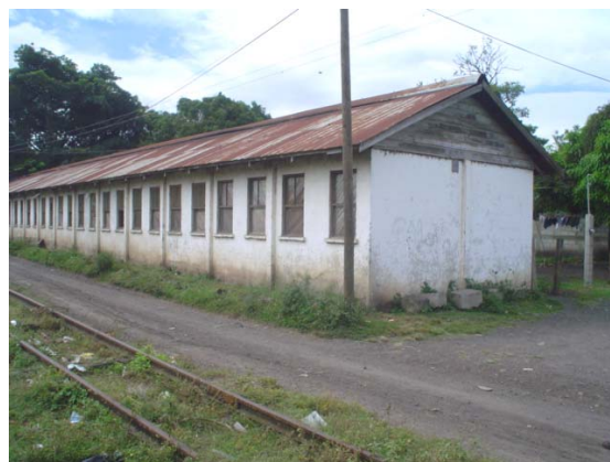
Foto 48. Perspectivas Fachada Oriente y culata Yarda de Peones 13 Módulos, en Estación Ipala fuente: Cesar Mota, año 2003.
