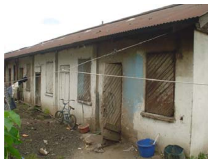
Foto 58. Vista de la Fachada Occidente de la Yarda de Peones 13 Módulos, fuente: César Mota, Octubre 2003.
