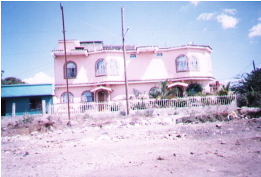
Foto 17. Construcción en el área urbana de mampostería en Ipala, fuente: César Mota, Febrero 2004.
