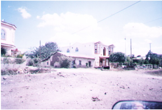
Foto 16. Contraste de construcción de mampostería y adobe casco urbano de Ipala, fuente: César Mota, Febrero 2004.
