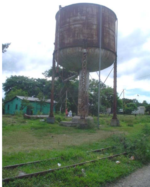
Foto 46. Tanque elevado de agua. Fuente: César Mota, Octubre 2003.
