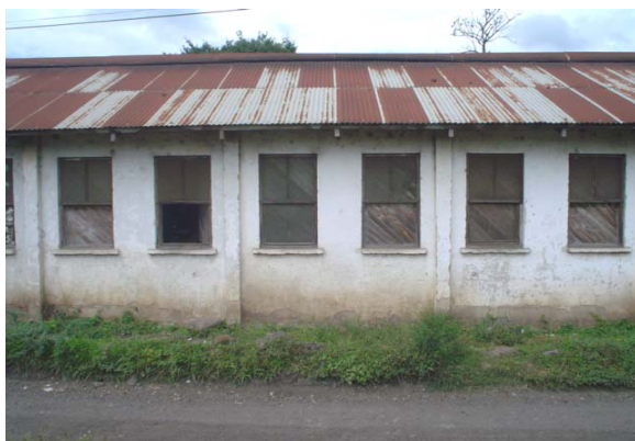
Foto 47. Fachada Oriente Yarda de Peones 13 Módulos, en Estación Ipala, Fuente: Silvia Rosales, Octubre 2003.
