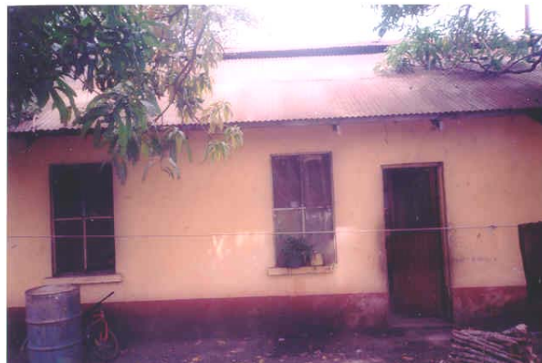
Foto 53. Fachada Sur Casa del caporal Primero, en la Estación Ipala fuente: César Mota, Octubre 2003.
