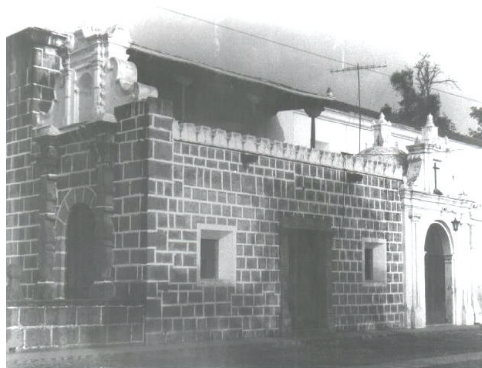
Fotografía No. 14: Elevación principal del convento. Fuente: CNPAG
