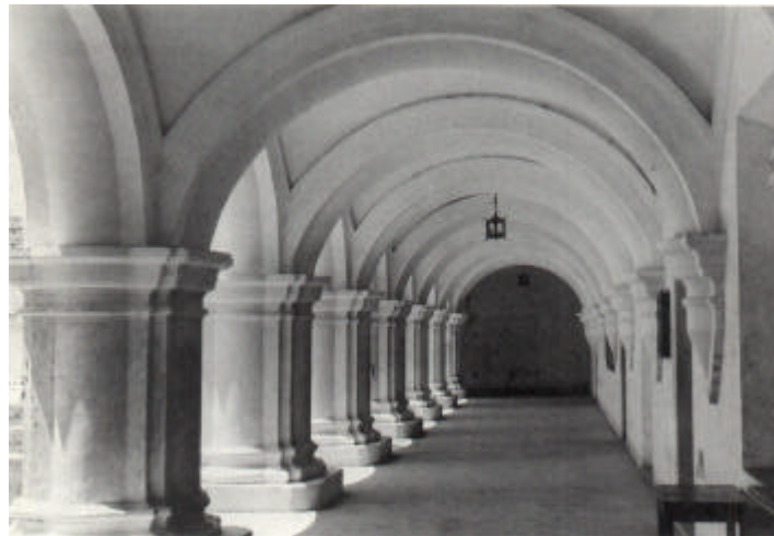
Fotografía No. 2 Corredor del Claustro de la Escuela de Cristo. Entre cada columna y arco se encuentra una bóveda vaida.
