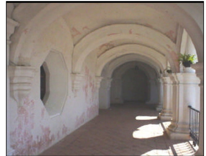
FOTOGRAFIA No. 17: Vista hacia el corredor del 2no. nivel. Claustro Escuela de Cristo, La Antigua Guatemala
