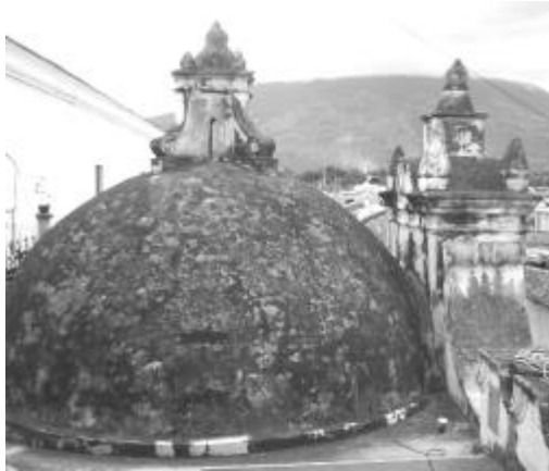
Fotografía No. 1 Detalle de cúpula ubicada en el paso adosado a la fachada del convento de la Escuela de Cristo.
