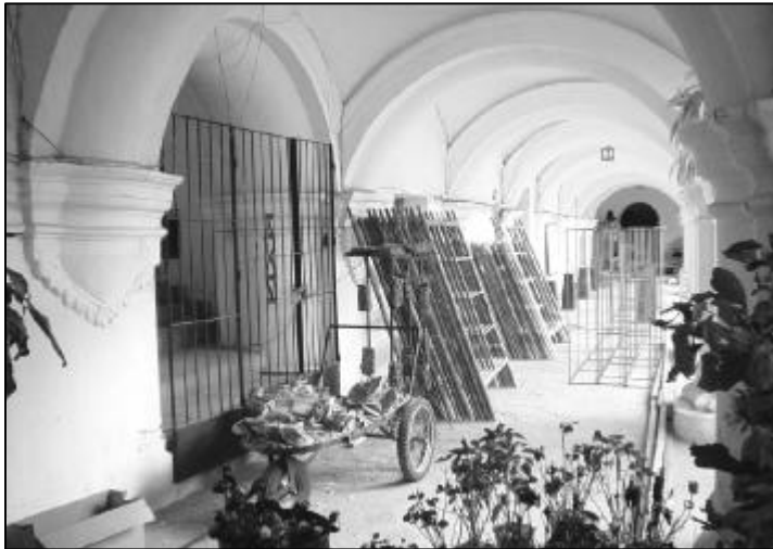
FOTOGRAFIA No. 38: No solo deterioros al monumento causa el no contar con bodegas, y espacios de trabajo, sino también contamina visualmente los espacios del convento. Claustro Escuela de Cristo, La Antigua Guatemala
