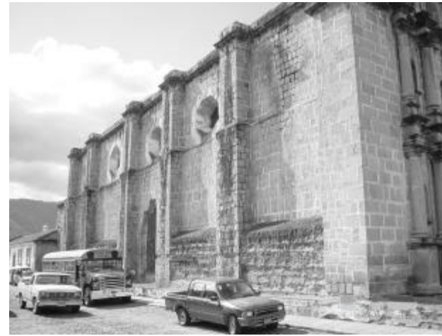
Fotografía No. 20: Vista lateral del templo de Capuchinas.
