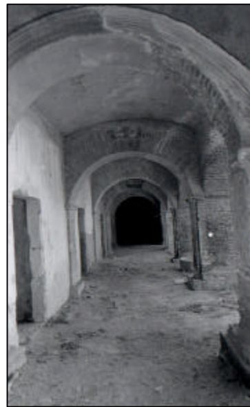
FOTOGRAFIA No. 11: Detalle de corredor realizandose trabajos de restauración. Claustro Escuela de Cristo, La Antigua Guatemala
