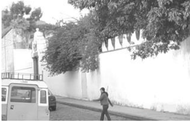
Fotografía No. 22: Fachada principal de la casa de la moneda.
