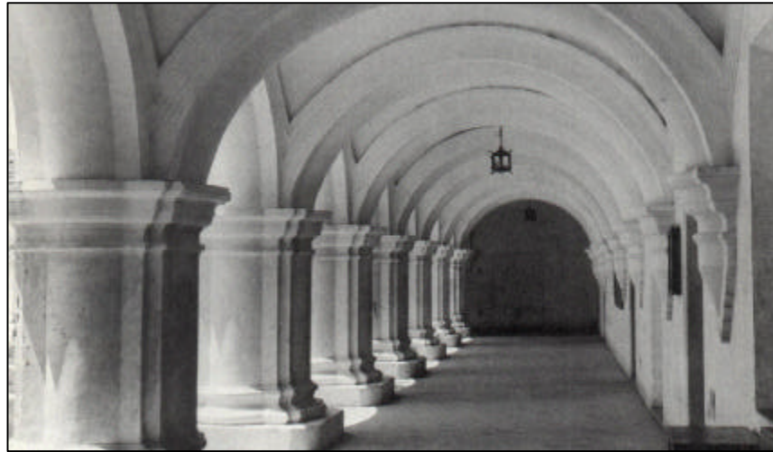
FOTOGRAFIA No. 9: Claustro de la Escuela de Cristo corredor sur, despued de ser restaurado en al año 1957 Claustro Escuela de Cristo, La Antigua Guatemala
