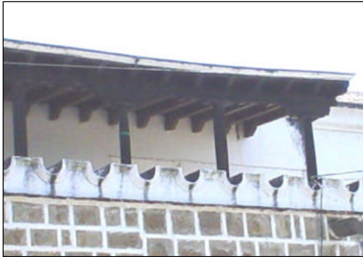
FOTOGRAFIA No. 23: Vista desde la calle de la terraza española ubicada en el segundo nivel.
