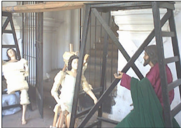
FOTOGRAFIA No. 5: Además de causar daños en el monumento, también obstruyen parte de la circulación vertical, como lo hacen al colocar utileria delante de las gradas. Claustro Escuela de Cristo, La Antigua Guatemala
