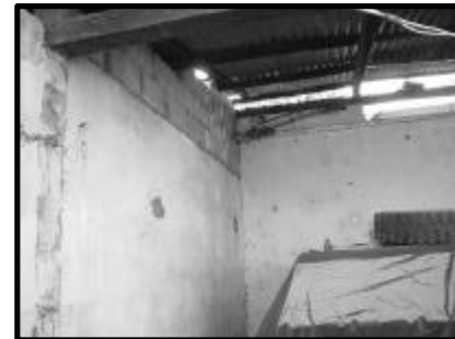
FOTOGRAFIA No. 42-a: Adecuación al espacio utilizado por la hermandad, usando material no tradicional. Claustro Escuela de Cristo, La Antigua Guatemala
