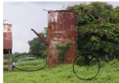
Foto No. 31 Presencia de cultivos perennes, (maíz y frijol) flora (hiedra silvestre) alrededor de las instalaciones de la estación.
