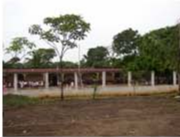
Foto No. 14 Vista de la Escuela de la Aldea Las Cruces
