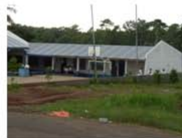
Foto No. 6 Vista de la escuela de la aldea San Miguelito.
