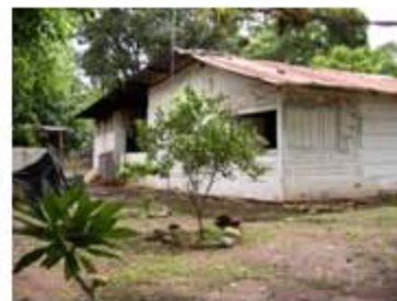
Foto No. 10 Vista de una de las casas de la Finca Las Ánimas.
