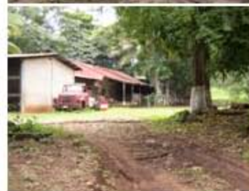
Foto No. 11 Vista de una de las casas de la Finca Las Ánimas.
