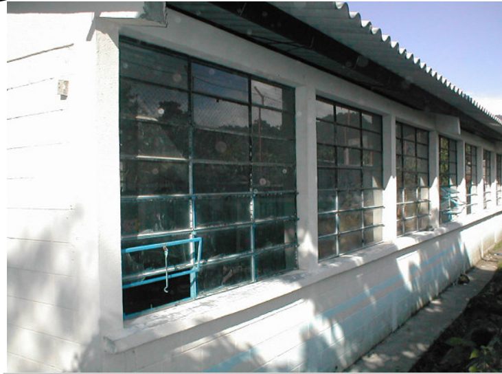
Fotografía No. 7 : Centro Educativo, comunidad Pacoc, San Lucas Tolimán, Sololá. En la fotografía se pueden apreciar las aulas
