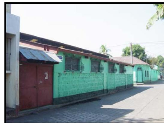
F6 Continuidad y homogeneidad de construcción, se ven cambios en los materiales, principalmente en la cubierta con lámina de zinc y puertas y ventanas con balcones de hierro.
