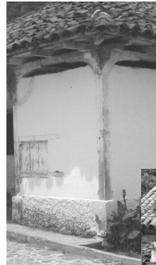
FOTO No. 36 El techo es de estructura de madera más teja de barro, paredes repelladas más cernidas y blanqueadas.
