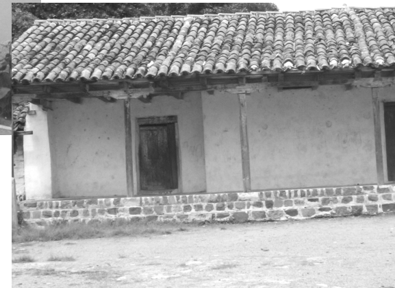
FOTO No. 37 Corredor al exterior, columnas de concreto y madera, e edificio esta sobre un nivel mas alto y la base es de piedra.
