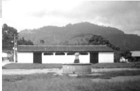
FOTO No. 5 Elevación Sur del Salón Municipal de Concepción
