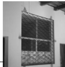
Instalación de balcones en ventanas dañando el muro
