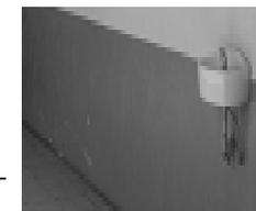
Instalación de bebedero sobre el área del corredor y se observa eflorescencia y humedad
