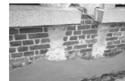
Se observa el material expuesto y recubrimiento de arena y cemento
