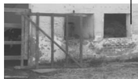
Desprendimiento de acabado, material expuesto, humedad y eflorescencia en el área de boxes
