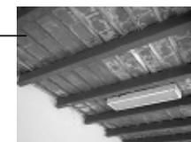
Se observa la presencia de humedad e la losa del corredor que simula una terraza española
