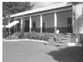
En la fachada frontal se observa la colocación de columnas de concreto las cuales sustituyeron a las originales de madera
