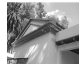
En la parte superior de la fachada frontal se observa eflorescencia y humedad
