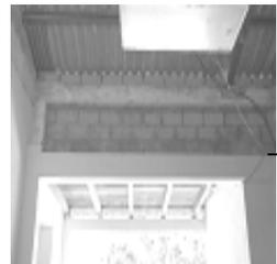
Vano tapado con block visto y área cubierta con estructura metálica y lámina asbestocemento
