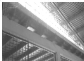
Instalación de estructura metálica y lámina de zinc la cual presenta oxidación, sobre lo que era un áreas de estar; actualmente es utilizado para salón de dibujo
