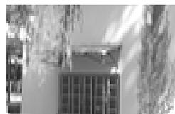
Abertura de vanos, colocación de balcón y una cubierta adosada de estructura metálica y lámina de zinc oxidada
