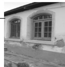
Material expuesto, humedad, eflorescencia y aplicación de acabado a base de arena y cemento
