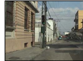
1. Postes instalados en la esquina de la 3ra calle y 7ma avenida, reducen el paso peatonal
