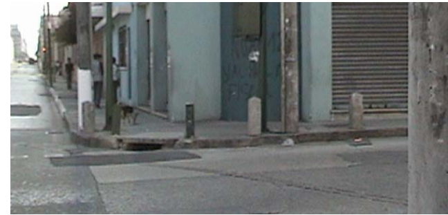
Fotografía 54: Bolardos de tubo metálico y de concreto instalados en la esquina sur de la 2da calle y 6ta avenida
