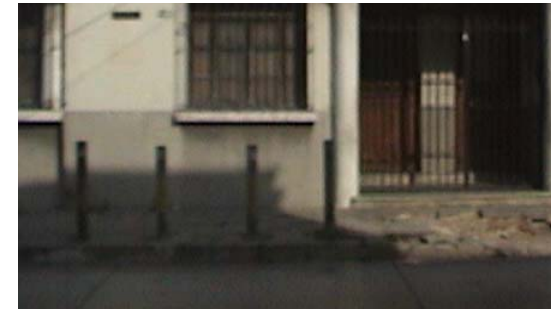
Fotografía 55: Bolardos de tubo metálico y concreto instalados en la esquina de la 6ta avenida y 1era. Calle
