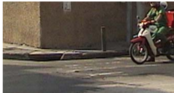
Fotografía 53: Bolardo de tubo metálico y concreto instalado en la esquina norte de la 2da calle y 6ta avenida
