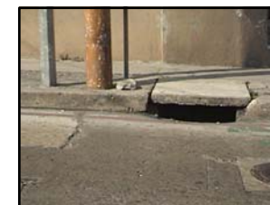
6. Alcantarilla ubicada en la 2da calle y 7ma avenida
