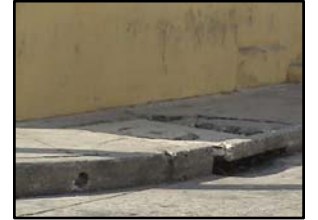
3. Alcantarilla ubicada en la 6ta ave "A" y 2da calle
