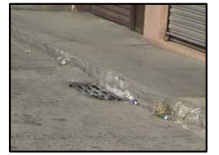
5. Alcantarilla ubicada en la 6ta ave "A" y 2da calle
