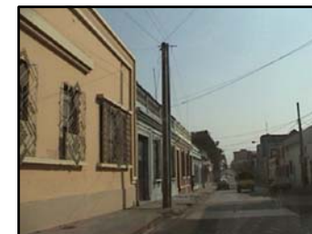
3. Poste instalado en la 6ta avenida entre 1ra y 2da calle
