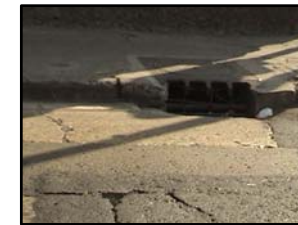
4. Alcantarilla ubicada en la 3ra calle entre 5ta y 6ta avenidas
