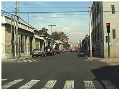
Foto 17 Segmento de la 3ª calle entre 6ª y 5ª avenidas.
