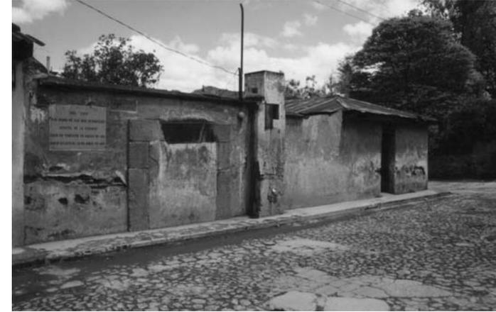
Foto # 03 Esquina calle Hermano Pedro y Fray Rodrigo, se observan deterioros como humedades, falta de materiales y alteraciones como vanos tapiados y utilización de materiales como lamina de zinc en la cubierta; además se observa deterioro en la calle misma.
