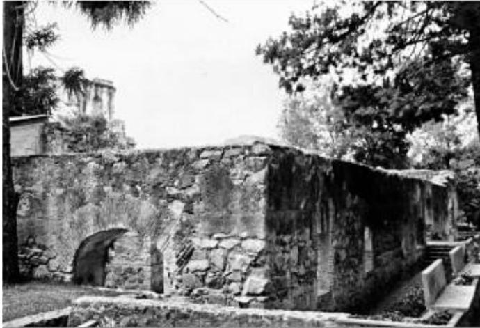
Foto # 30 Esquina de las ruinas, mampostería expuesta, no hay puertas, se observa parte del entorno.
