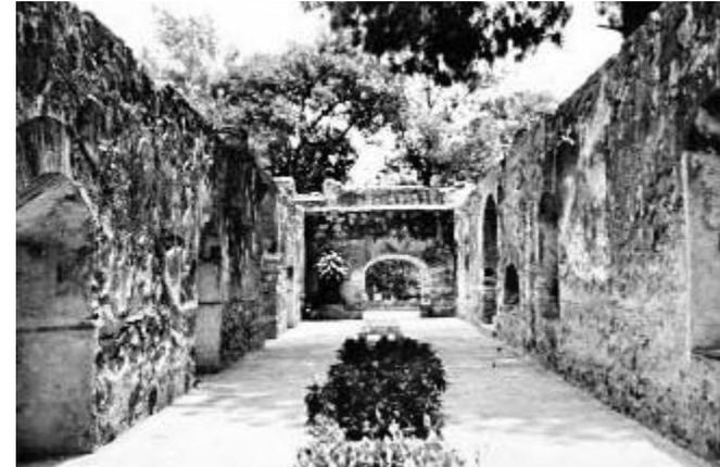
Foto # 29 Interior muros expuestos a erosión, humedad, flora, agregado de piso de concreto.
