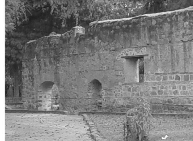
Foto # 28 Fachada donde se observa mampostería expuesta, no hay puertas ni ventanas; diferencia de niveles exteriores.
