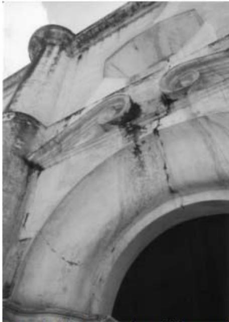
Foto # 21 Fachada lateral, en el arco de la puerta lateral algunas grietas, fisuras y humedades.
