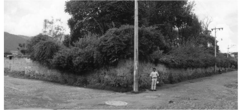
Foto # 07 Parte del entorno inmediato donde se observa muros de mampostería de cal y canto sin recubrimiento y con vegetación abundante, también falta de banquetas y deterioros en la calle.
