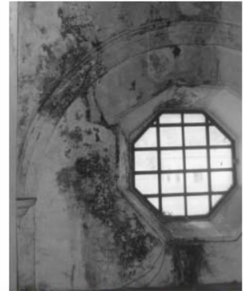
Foto # 25 Interior se notan humedades y algunas fisuras en muro y cubierta.
