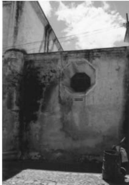
Foto # 15 Fachada lateral, manchas de humedad por deterioro de bajadas de agua pluvial (gárgolas).
