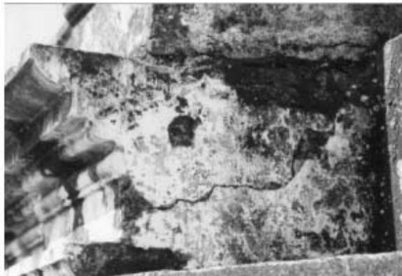
Foto # 16 Fisuras, faltante de materiales y humedad en algunas molduras.
