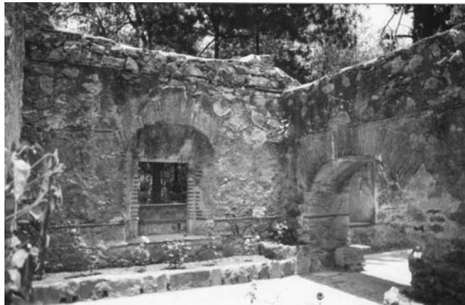
Foto # 31 agregados como pisos de concreto en el interior, daños en muros, falta de cubierta.
