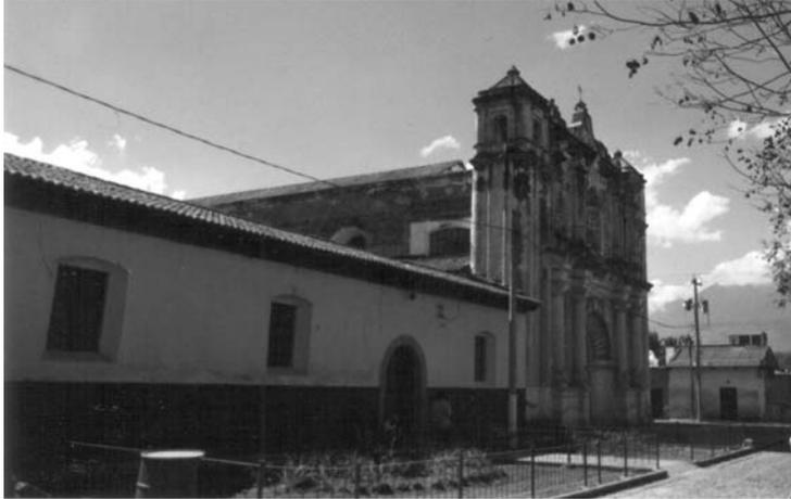
Foto # 01 Fachada casa Hermanas Bethlemitas, muros de cal y canto, repellos de arena y cal con pintura a base de cal, techo de teja, puertas y ventanas de madera.
