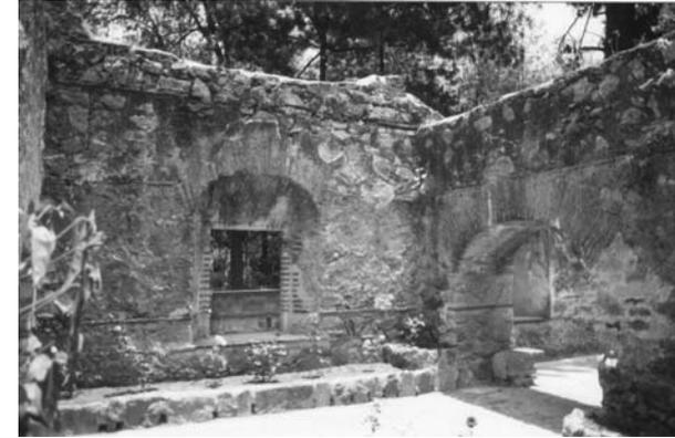
Foto actual donde se observa la falta de entrepiso, muros del segundo nivel y la cubierta
