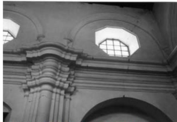
Foto # 23 Interior del templo, algunas fisuras en muro lateral derecho y columnas.
