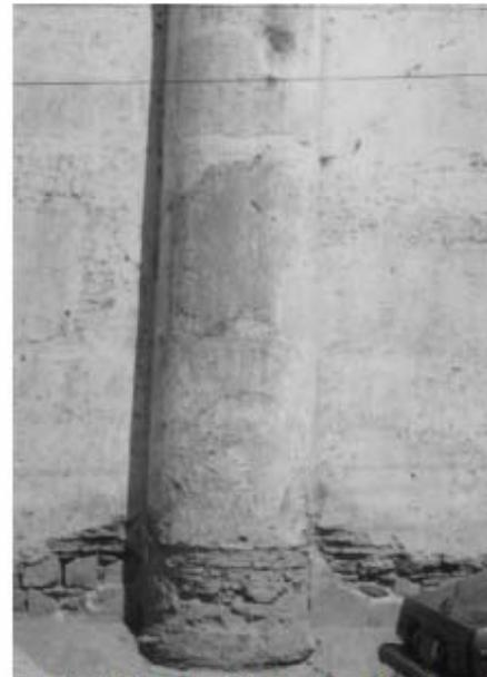
Foto # 18 Fachada lateral, faltante de acabados en la base de un contrafuerte.
