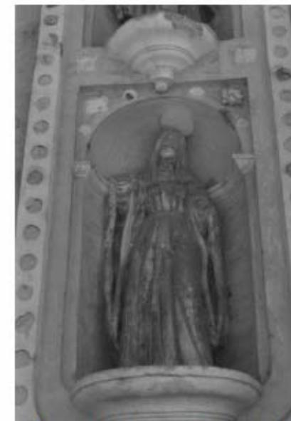
Foto # 14 Hornacina en la Fachada frontal, se observa faltantes de acabados y despostillamientos.
