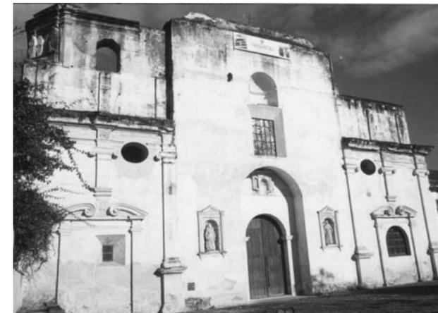
Foto # 12 La fachada del Templo donde se observan deterioros sobre todo en el campanario derecho desaparecido por completo así como fisuras, humedades etc.
