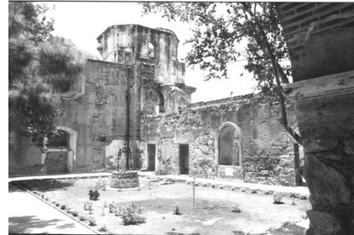
Foto # 32 Claustro interior, daños en muros de mampostería expuesta a la humedad, erosión, microflora, alteración en pisos, agregados, falta de puertas y ventanas, falta de columnas del claustro.
