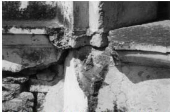
Foto # 22 Molduras donde se nota fisuras y faltante de acabados.
