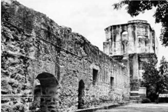
Foto # 26 Fachada actual al fondo campanario Templo de Belén; se observa falta de revestimientos en muros, expuestos a la intemperie, humedad, microflora.
