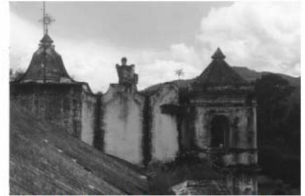
Foto # 19 Cubierta del templo, presencia de microflora, manchas por humedad y deterioros en la cubierta.
