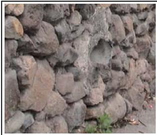
Detalle de colocación de piedras, para formar el cimiento este sistema es utilizado en todas las viviendas.
