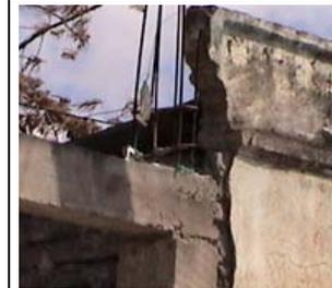
Aquí se observa, el deterioro producido por la humedad y por una demolición.
