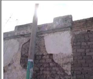
Detalle de muro, con repello en estado de deterioro.
