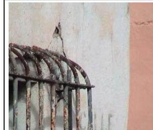
Detalle de oxidación de balcón, daño en el muro por grietas y decoloración.
