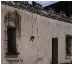
En este detalle, se observa los cables de la acometida de electricidad suspendidos al aire.
