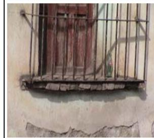
Detalle de base de ventana y balcón, muestran deterioro por oxidación y erosión.
