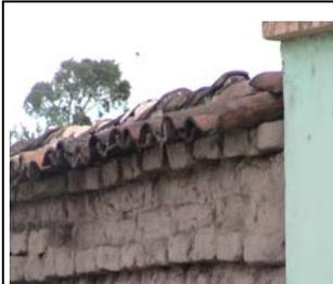
Detalle de unión de muro de adobe, con techo de teja.
