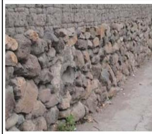
Detalle de cimentación de piedra, expuesta por cambio de nivel de los muros.
