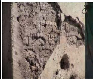
Detalle de muro, donde se puede notar la intervención de concreto sobre el muro de adobe..
