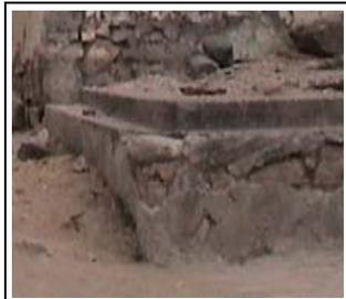
Detalle de cimentación escalonada para formar cambios de nivel en la vivienda.
