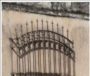
Detalle de balcón forjado, deteriorado por oxidación, muro dañado por humedad y hongos.
