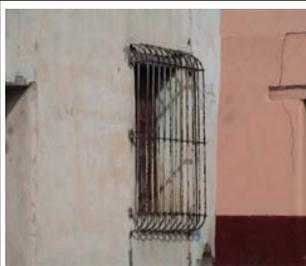
Vista total de balcón oxidado, muro decolorado con agrietamiento de repello.
