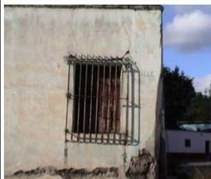
Detalle de balcón de fachada principal, dañado por oxidación, el muro dañado por humedad.
