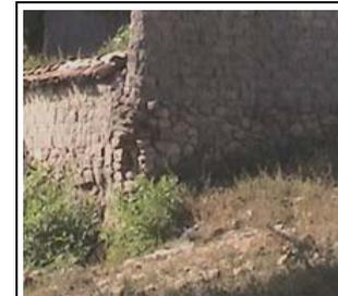
Detalle de cimiento en muro de cerramiento (tapial), en donde el cimiento sirve de contención.
