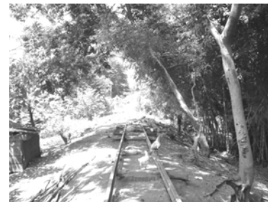
Imagen 68: Ubicación de la estación de El Pilar. Fuente: Visita de Campo 2004.
