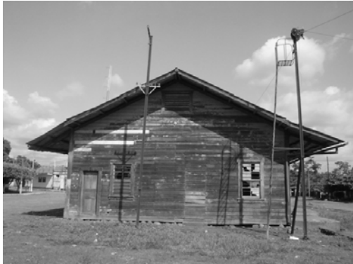
Imagen 26: Estado actual de la Estación de Pajapita. Fuente: visita de campo 2004.
