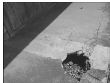
Imagen 103: La mayoría de elementos fundidos de aquella época, tienden a rajarse o agrietarse, como en este caso, ya que en ese entonces no solían usar el hierro para mezclas de cemento.
