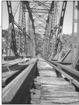
Imagen 56: Puente que atraviesa el río Meléndrez. Se encuentra en la milla 372.79.
