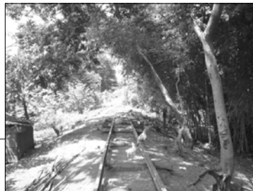
Imagen 37: La mayoría de invasiones encontradas son estructuras improvisadas.
