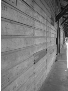
Imagen 79: Muestra los muros del edificio en su parte Sur. Fuente: Visita de Campo Octubre 2004.
