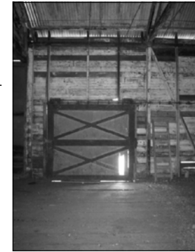
Imagen 102: Este portón carece de una pieza de su estructura, así como también le falta un pedazo bastante notorio, y es en espacios como éste donde se cuele la lluvia o los animales.
