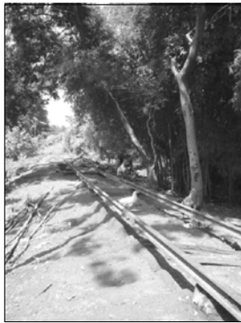
Imagen 36: En varias partes del tramo los rieles se encuentran casi en el aire, ya que los invasores arrancan los durmientes.
