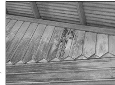
Imagen 109: Este es uno de los tantos acabados peculiares de la estación de Pajapita, sin embargo, este como muchos otros, se encuentran dañados por diversos agentes, entre ellos, las polillas, que poco a poco van deteriorando y acabando con la madera del edificio.
