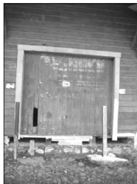
Imagen 115: Como ya es típico en cuanto a los deterioros, a este portón le hace falta una pieza, además tiene pegados algunos afiches, que poco a poco van dañando la forma original.
