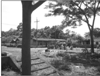
Imagen 88: La plataforma de concreto se encuentra en buen estado, solamente tiene algunos desgastes y rajaduras.
