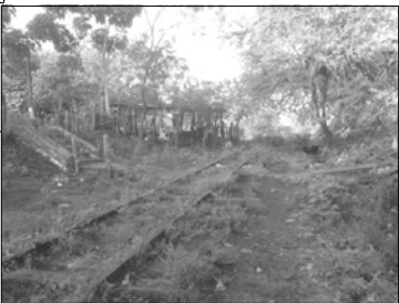
Imagen 47: Invasiones a lo largo de la vía férrea, aproximadamente desde la milla 366-15 a la 366-20.
