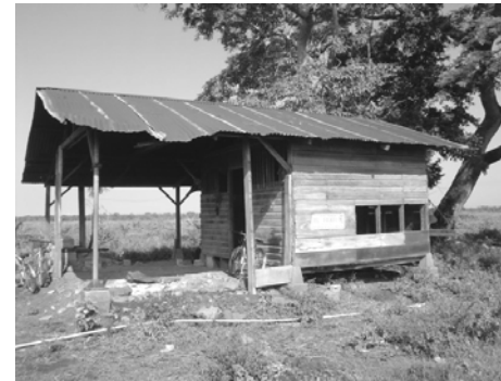
Imagen 18: Bodega desolada en Finca El Prado. (no es infraestructura ferroviaria) Fuente: Visita de campo 2004.
