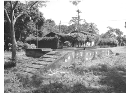
Imagen 71: Plataforma donde se encontraba la estación de Las Palmas. Fuente: Visita de Campo, Octubre 2004.
