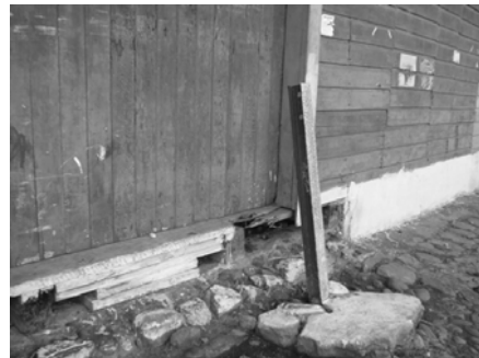
Imagen 76: Sistema de Cimentación con vigas de Madera. Fuente: Visita de Campo Octubre 2004.
