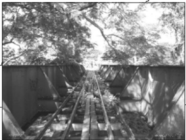
Imagen 57: Continuación de puente.
