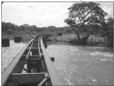
Imagen 45: Puente "Vado Ancho", el cual atraviesa el río El Naranjo. Su estructura se encuentra en buenas condiciones, sin embargo ya no posee sus durmientes. Mide aproximadamente unos 150m de largo.
