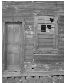
Imagen 80: Estructura de puertas y ventanas. Fuente: Visita de Campo 2004
