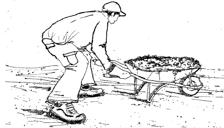
Transporte de concreto en carretilla
