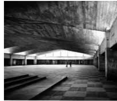
Ejemplos de Estructuras de Concreto en forma de Paraboloides Hiperbólicos. (42)
