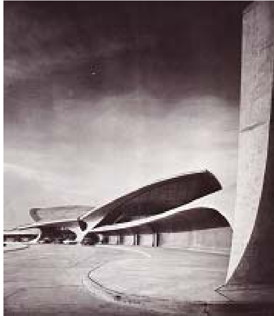
TERMINAL AEREA DE LA TWA, Aeropuerto Internacional Kennedy, CASCARON DE FORMA LIBRE
