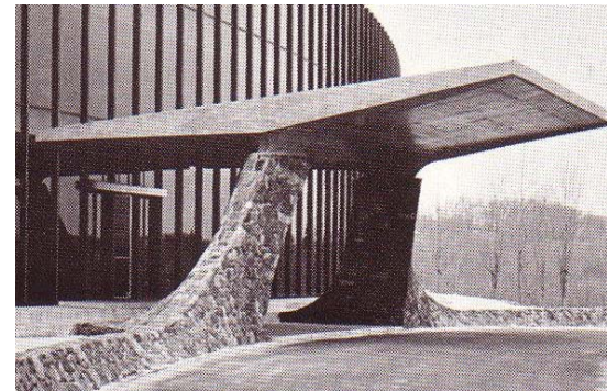
ENTRADA A IBM, YORKTAWN, VIGAS Y MARQUESINA EN VOLADIZO. (44-A)
