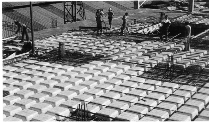
FORMALETA DE MADERA PARA LA CONSTRUCCIÓN DE LOSAS RETICULARES (46)
