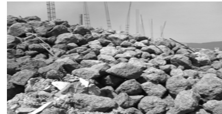
pedra para concreto ciclópeo (6)
