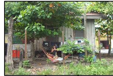
12. VIVIENDAS INDIVIDUALES CONSTRUIDAS SOBRE PILOTES.
