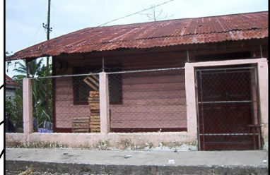
8. JUNTO AL DERECHO DE VÍA SE CONSTRUYERON UNA SERIE DE VIVIENDAS PARA LOS TRABAJADORES DEPENDIENDO DEL RANGO.
