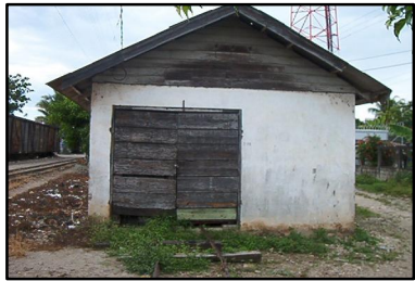
11. CONSTRUCCIONES PARA MANTENIMIENTO DE LAS MÁQUINAS QUE SUPERVISABAN LA VÍA FERREA LLAMADAS TAMBIÉN COMO (OIL HOUSE) CONSTRUIDA DE MAMPOSTERÍA Y TECHO DE ARMADO DE MADERA + CUBIERTA DE LÁMINA.
