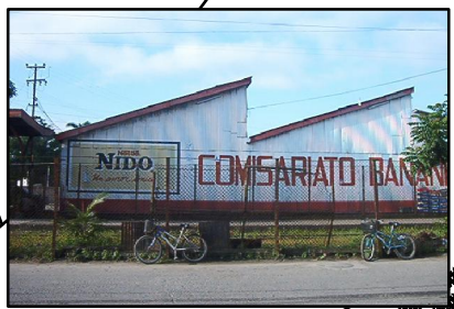
3. COMISARIATO JUNTO A LA ESTACIÓN DEL FERROCARRIL, QUE TAMBIÉN FORMABA PARTE DEL CONJUNTO HISTÓRICO.
