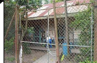
9. ALGUNAS DE LAS VIVIENDAS CONSTRUIDAS DE MADERA ALGUNAS EN ESTADO REGULAR.
