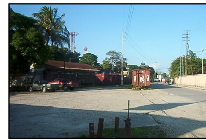
6. VISTA DE LA PARTE POSTERIOR DE LA ESTACIÓN DEL FERROCARRIL DESDE EL INGRESO A BANDEGUA.
