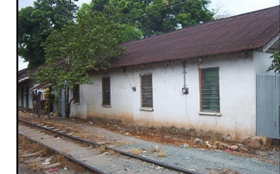
10. OTRO TIPO DE VIVIENDAS CONSTRUIDAS DE MAMPOSTERÍA.
