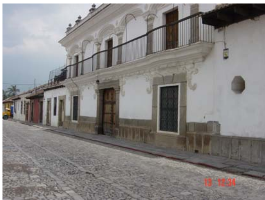
Limite Casa Hogar con Casa Chamorro Fuente: Propia Fotografía No. 14.
