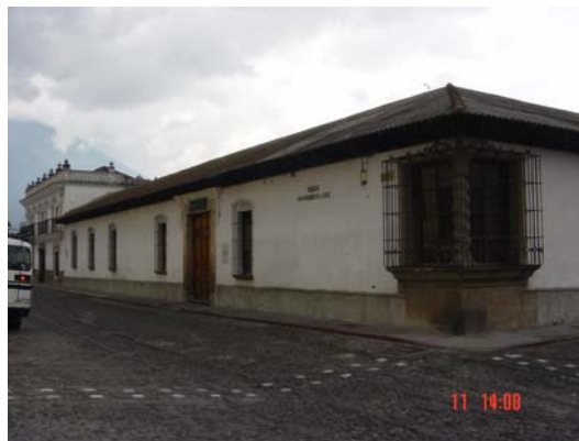
Vista esquina sobre 4ª. Avenida Sur Fuente: Propia Fotografía No. 15.
