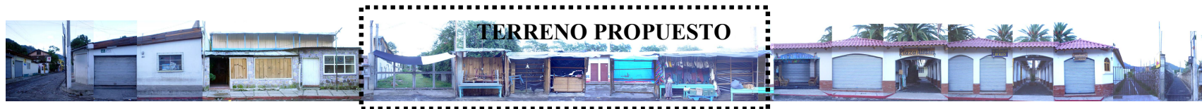
Colindancias del Terreno Propuesto Fotos: Netzer Ramírez
