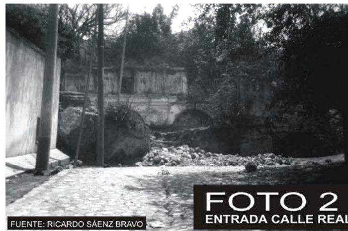
Calle Real de Santa Inés vista hacia la Ermita. Se observa la variada vegetación alrededor de las Ruinas.
