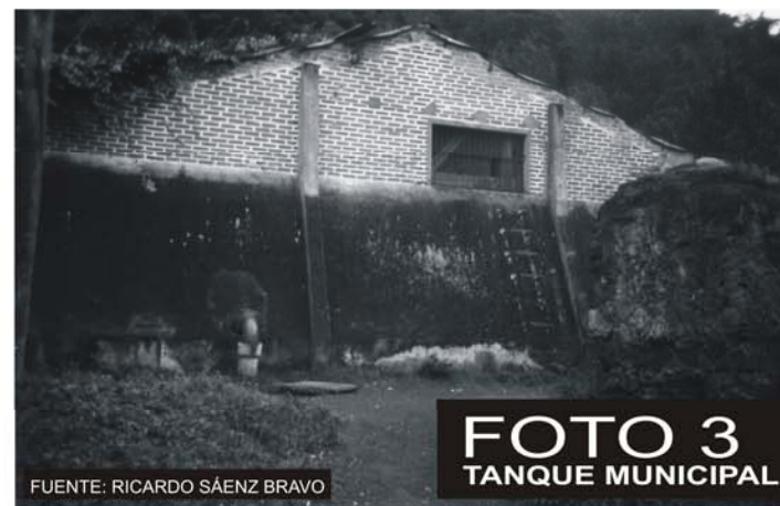
Vista en general del Tanque de Agua Municipal sobre el callejón Oeste, con su muro de contención y un mojinete de mampostería de ladrillo y un techado de lámina de Zinc.
