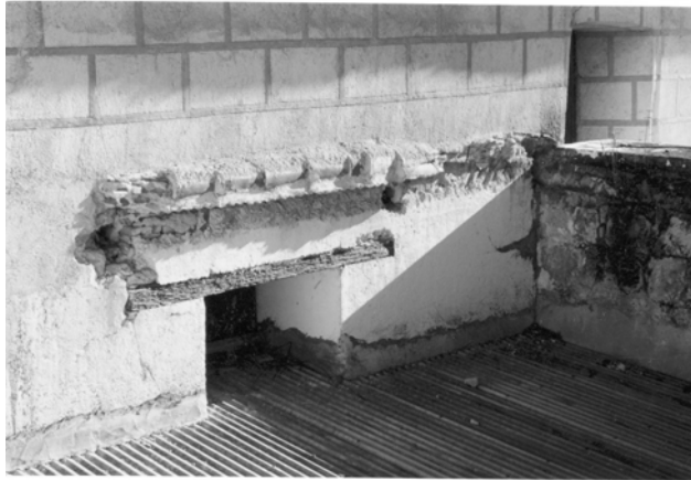
Fotografía No.27 daños en cubierta y muro de Capilla lateral (fachada sur)
