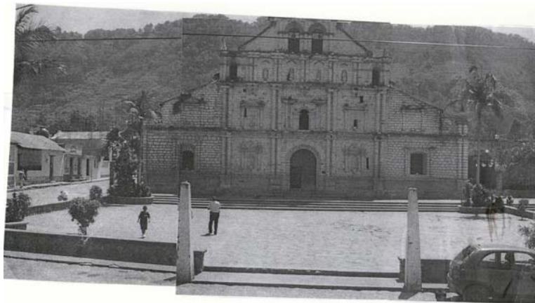
Fotografía 17 Vista de la fachada principal (oeste) y atrio.
