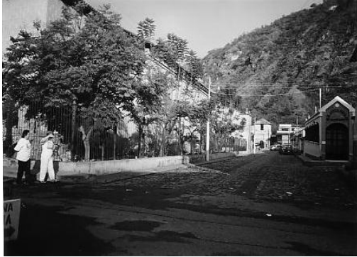
Fotografía No.13 Vista lado norte del templo
