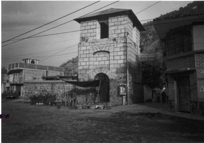
Fotografía No.9 Vista de la capilla posa.
