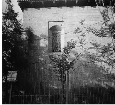
Fotografía No.14 Fachada de lado norte.
