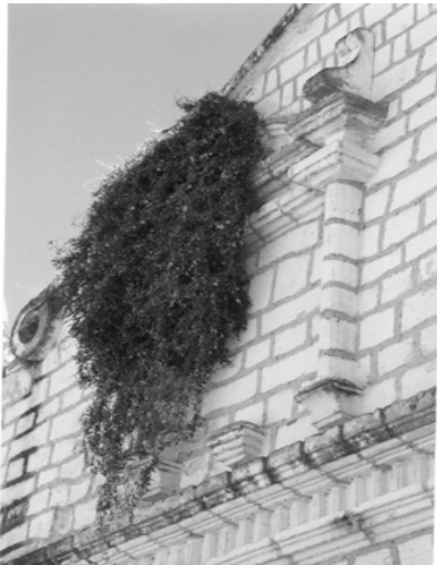
Fotografía No.27 daños en cubierta y muro de Capilla lateral (fachada sur)
