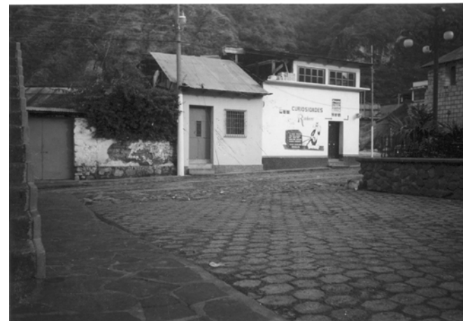
Fotografía No. 8 Vista final calle del campanario.
