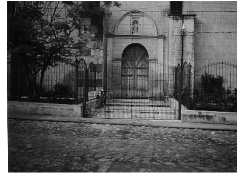
Fotografía No.15 Ingreso lateral fachada norte.
