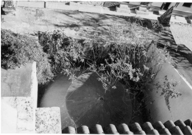
Fotografía No.31 daños y deterioros en cúpula Del baptisterio (fachada norte)
