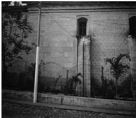
Fotografía No.16 Detalle de contrafuertes.
