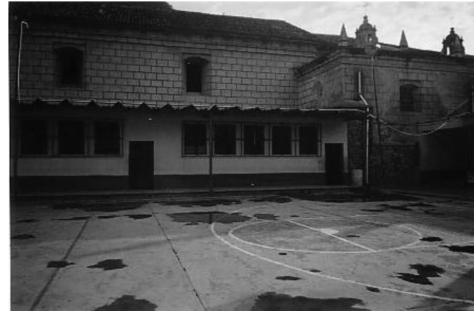
Fotografía No.19 vista de la sacristía-fachada sur.
