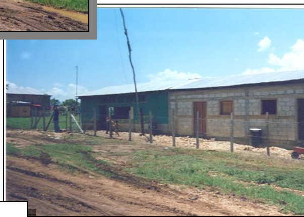
FOTOGRAFIA No.24 Vivienda de block.
