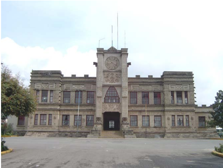
Fotografía del estado actual del Edificio Palacio Maya de San Marcos Fotografía: Lorena González
