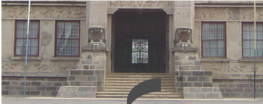
Puerta de Ingreso Principal al Edificio
