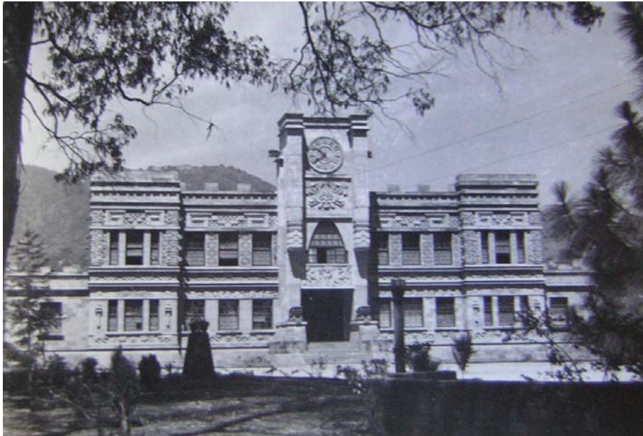
Vista frontal del edificio Palacio Maya desde el jardín Simón Bolívar.
