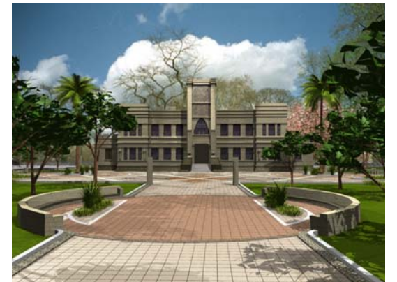
Vista frontal del edificio desde el ingreso peatonal principal
