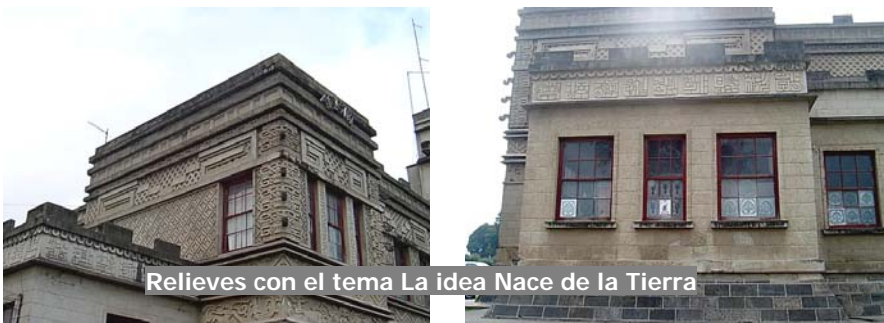
Ladrillo de cemento con jeroglíficos. Ventanas decoradas con mascarones mayas
