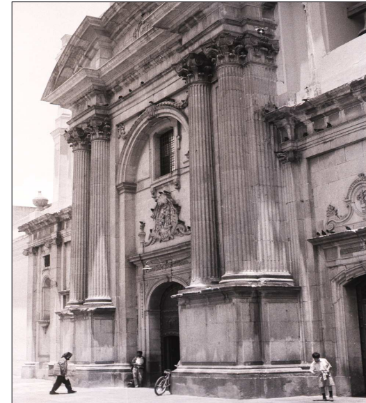
La fotografía nos muestra el orden compuesto de sus columnas
