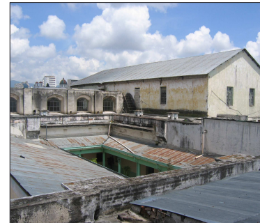
Liberación de cubiertas de zinc.
