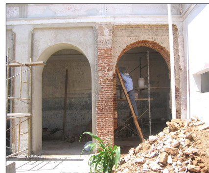
Liberación de tapiados en arcos y reconstrucción de columnas.
