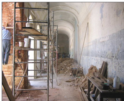
Liberación de disgregados de materiales, calas arqueológicas para determinar existencia de piso original.
