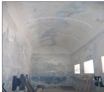
Liberación de acabados en mal estado, liberación de tapiado en arcos, aplicación de pintura a base de cal, limpieza de muros.
