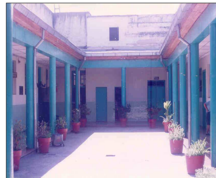
Liberación de construcción de corredor y muros no originales.
