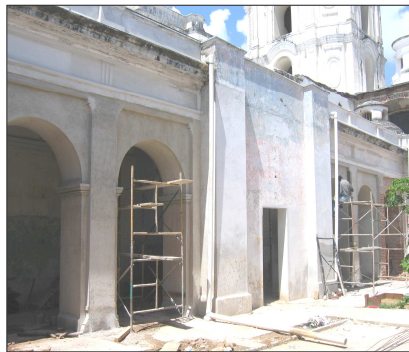
Liberación de arco mayor central tapiado
