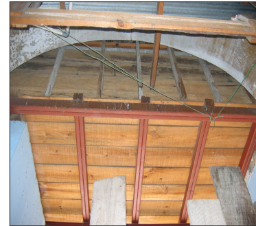
Liberación de entrepisos de madera en parte superior de arcos.
