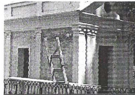
Algunos propietarios han empezado a dar el mantenimiento a sus edificaciones.
