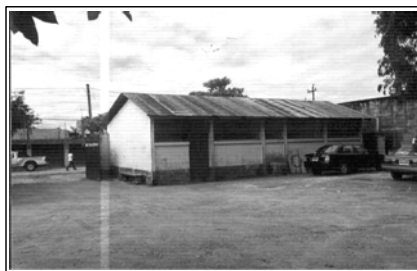
FOTO No. 31: VISTA POSTERIOR DEL EDIFICIO DE CORREOS.
