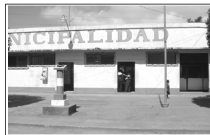
FOTO No. 35: VISTA ANTERIOR INGRESO PRINCIPAL A EDIFICIO MUNICIPAL.
