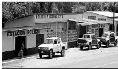
FOTO No. 8: EDIFICIO POLICÍA NACIONAL CIVIL
