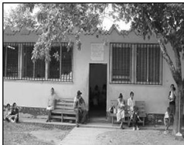
FOTO No. 5: VISTA INGRESO CENTRO DE SALUD
