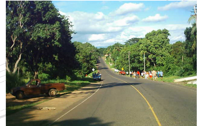
Carretera CA-2, Vía principal a proyecto.
