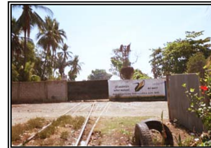
Foto No.85. Esta imagen presenta uno de los ingreso de los ferrocarriles, éste se ubica al sur-oeste del predio de la estación; nótese la combinación de materiales con block visto y portones de metal. Fuente: Elaboración propia.
