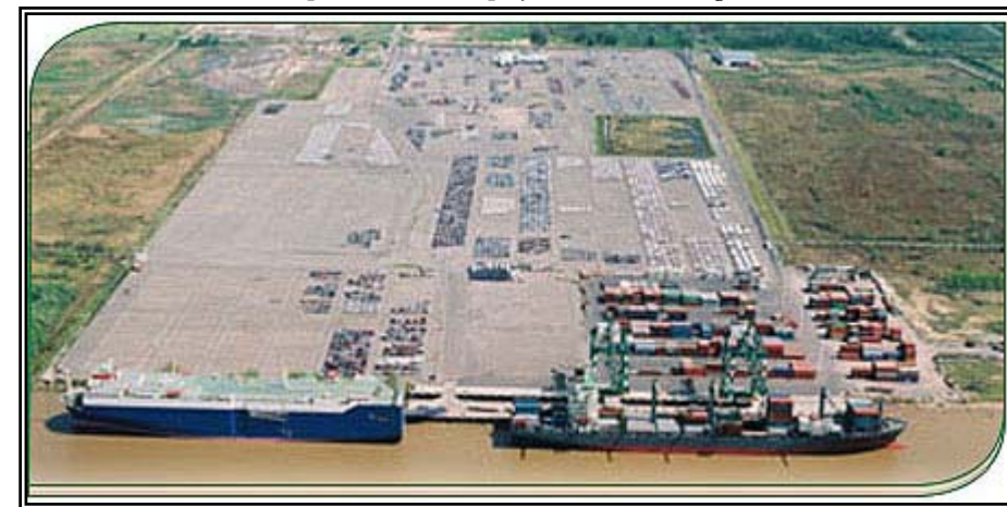
Foto # 54. Terminal Zárate, Argentina. Fotografía aérea de las instalaciones. Fuente: www.logisticazarate.com.ar
