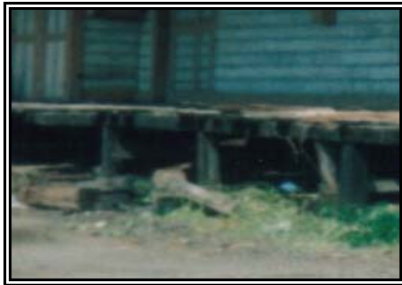
Foto No.82, en esta imagen se observa que la base de cimentación de la estación de pasajeros es de pilotes de concreto. Fuente: Elaboración propia.
