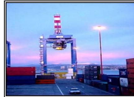
Foto # 33. Toma de grúa tipo Pórtico trabajando. Fuente: www.lenguajeintermodal.com
