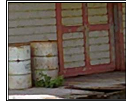
Fotos No. 93 y 94, ambas tomas muestran el estado de las puertas, estas ya desfasadas, desniveladas y se nota en sus marcos el desprendimiento de la pintura.
