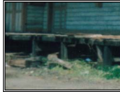
Foto No. 95 muestra el tipo de piso de las bodegas en la Foto No. 96 se observa el piso de la estación de pasajeros el cual es de madera, notase las piezas de madera desprendidas.
