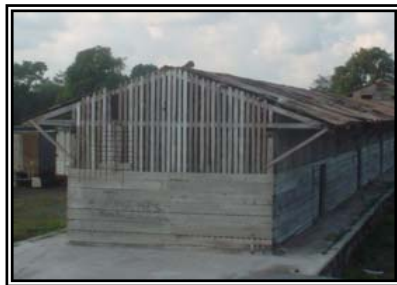
Foto No.83. Para las bodegas se utilizó losa de cimentación conformada por una plancha de losa de cimentación. Fuente: Elaboración propia.
