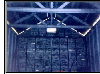
Foto No.84. Nótese que la estructura vertical interna es por medio de parales, con techo de estructura tipo Pratt. Fuente: Elaboración propia.
