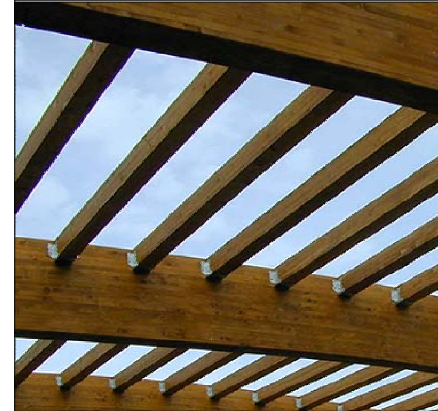
DETALLE DE ESTRUCTURA DE TECHO
