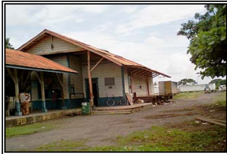
Foto No. 86. Los acabados son aplicación de pintura en el caso de la estación, mientras que a las bodegas se le aplicó cal, los techos son de lámina de zinc, calibre 21, con aplicación de pintura anticorrosiva. Fuente: Elaboración propia.
