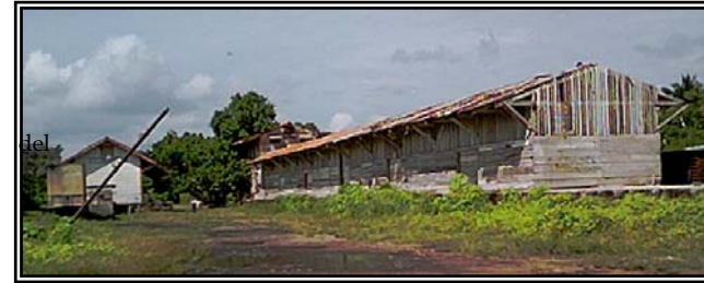
Fotos # 78,79 y 80. Perspectivas estado actual del edificio de bodegas de Ayutla, de la bomba y la grúa pórtico en Ayutla, Tecún Umán. Fuente: Elaboración propia
