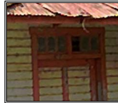
Fotos No. 93 y 94, ambas tomas muestran el estado de las puertas, estas ya desfasadas, desniveladas y se nota en sus marcos el desprendimiento de la pintura.
