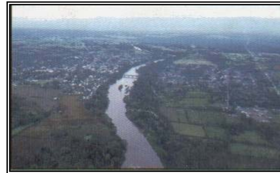
Foto No. 60. Toma aérea del Río Suchiate y Puente Rodolfo Robles. Derecha Ciudad de Hidalgo, Izquierda Ciudad Tecún Umán. Fuente: Fabrica de Aceites, Tecún Umán, Ayutla.
