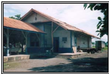
Foto No. 77. Perspectiva del estado actual del edificio de la estación de pasajeros de Ayutla, Tecún Umán. Fuente: Elaboración propia.
