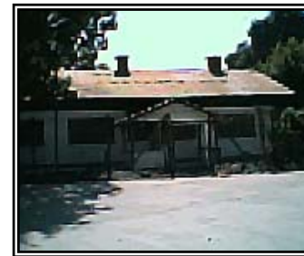
Foto No. 81. Perspectiva del estado actual de la Casa del Agente de Ayutla, Tecún Umán. Fuente: Elaboración propia
