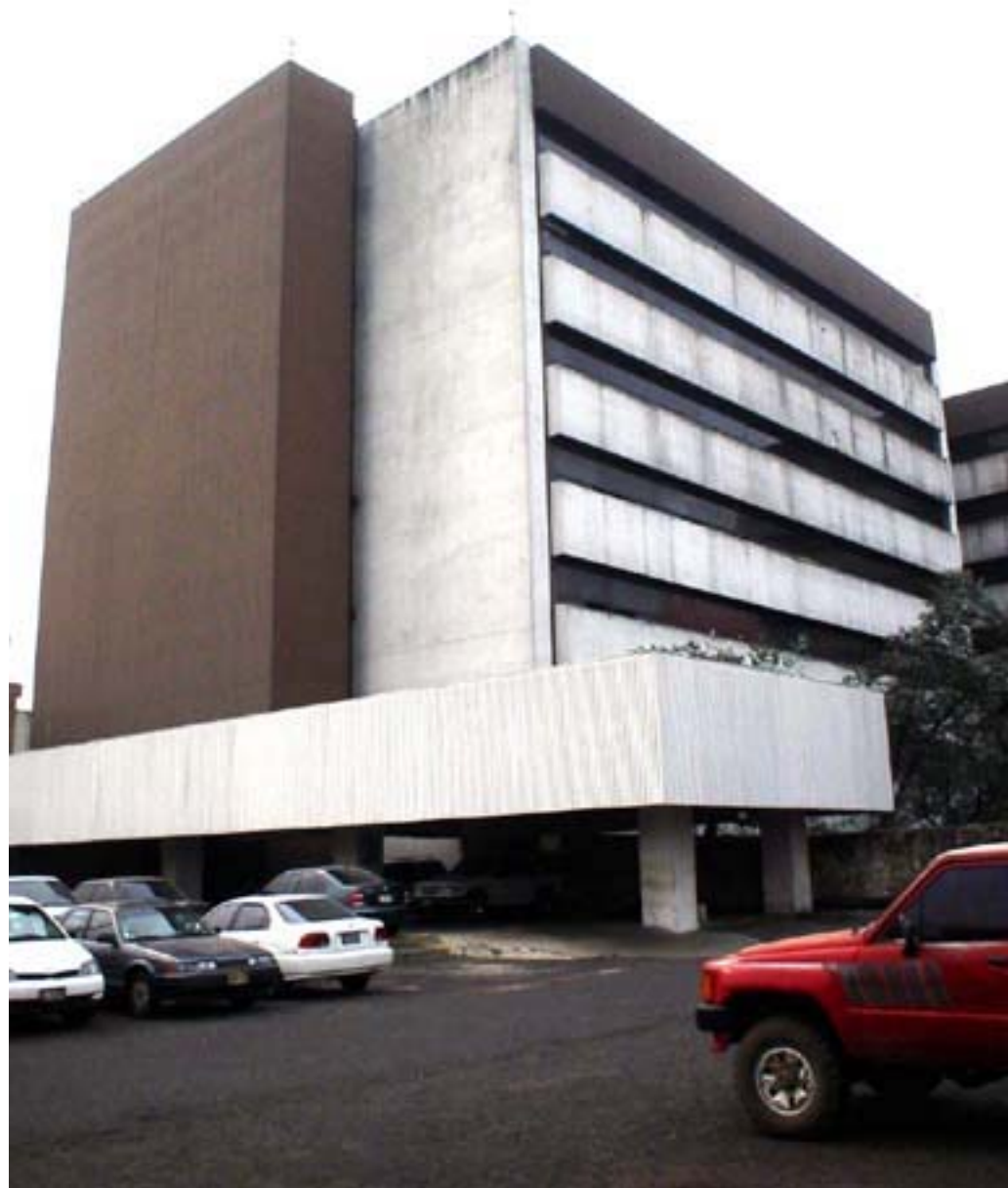
Fotografía No. 12. Vista del edificio actual del Hospital, sobre la 9ª. Calle "A". Elaboración propia, 2004.
