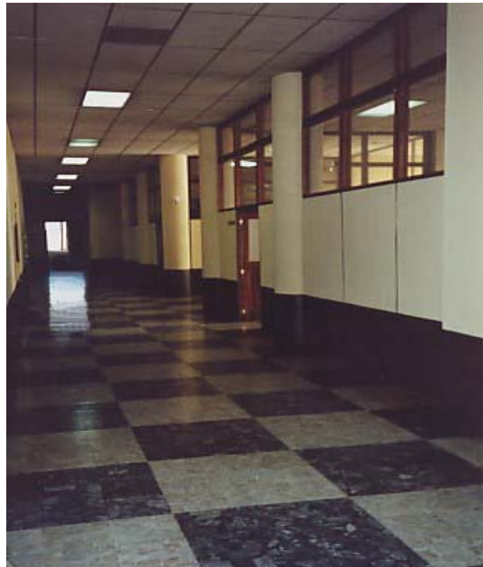
Detalle de corredor principal en el tercer nivel. A la derecha, los tabiques del salón de Inventarios
