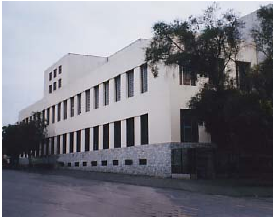
VISTA DE FACHADA SUR
