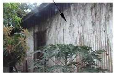
MUROS DE LÁMINA DETERIORADA CON ESTRUCTURA DE MADERA EN MAL ESTADO
