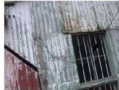
MUROS DE LÁMINA DETERIORADA CON ESTRUCTURA DE MADERA EN MAL ESTADO
