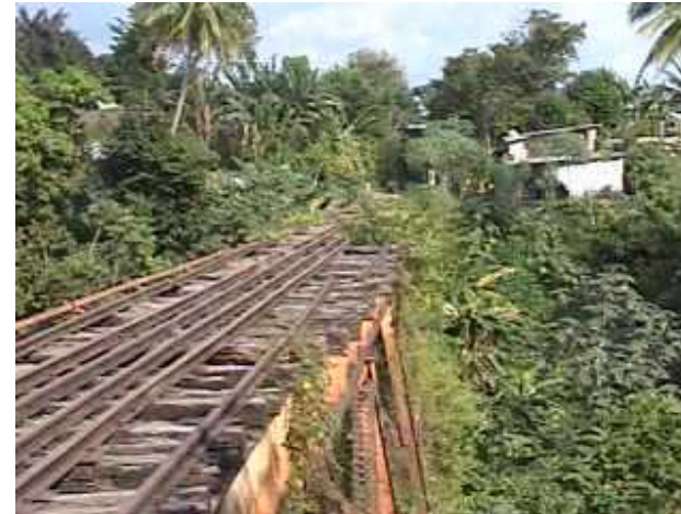
Se puede calcular que el puente posee unos 80 metros de longitud sobre un pequeño río de aguas servidas. Foto No 14
