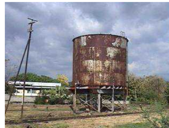
Depósito de petróleo, se encuentra al final. Foto No 47
