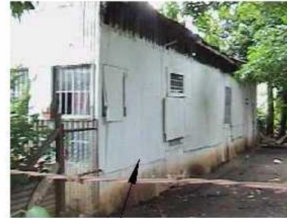
MUROS DE LÁMINA DETERIORADA CON ESTRUCTURA DE MADERA EN MAL ESTADO
