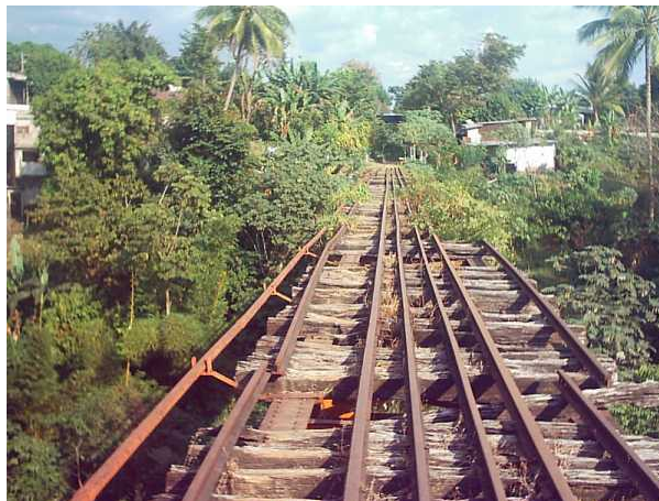
Puente existente al oriente de la estación, puede verse el mal estado en que se encuentra. Foto No 13
