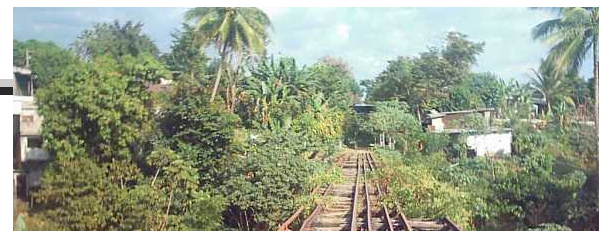
Vista lateral del puente que se encuentra al final de la estación. Foto No 61
