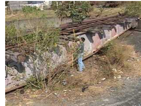
Consola ubicada en la estación de Mazatenango. Foto No 38
