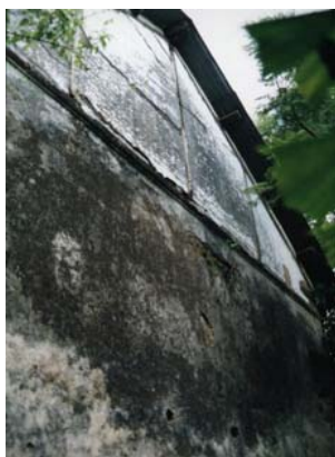
Fotografía No.10 Fachada posterior de la Capilla
