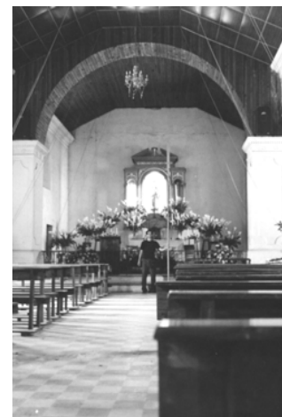
Fotografía No. 4 Detalle de la nave
