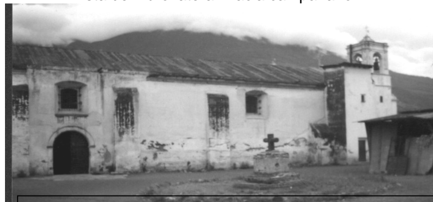
Fotografía No.6 Vista de muro lateral hacia campanario
