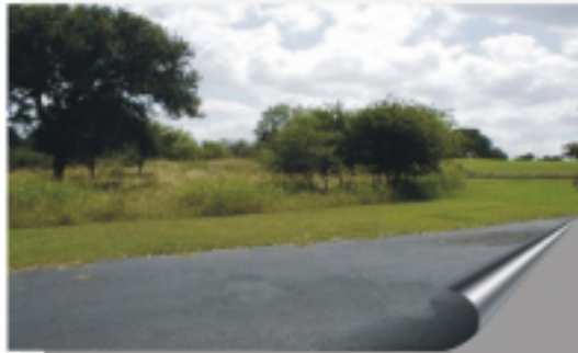
Fotografía T-5 Sitio No. 2, Ubicado sobre la Carretera Centro Americana CA-10 Kilómetro No. 200.00.
