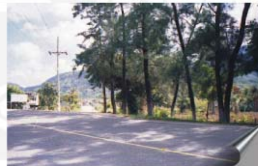
Fotografía T-14: Carretera Centroamericana CA-10 Kilómetro 196.5
