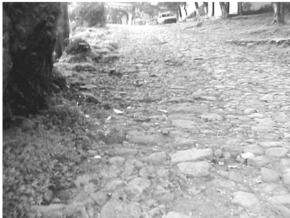
FOTOGRAFÍA No.15: Caminamiento está deteriorado por el paso de vehículos dentro del caso del conjunto de la Finca Medio Monte.
