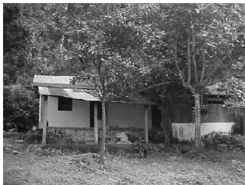
FOTOGRAFÍA No 20: Fachada Principal actualmente habitada
