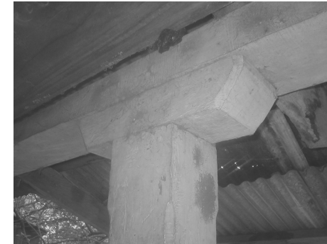
FOTOGRAFÍA No.3: DETALLE de pilastras de madera ubicadas tanto en Casa Patronal y Administrativa.
