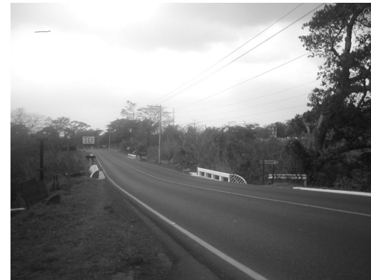
FOTO No2. Se puede observar puentes, postes de luz eléctricas.
