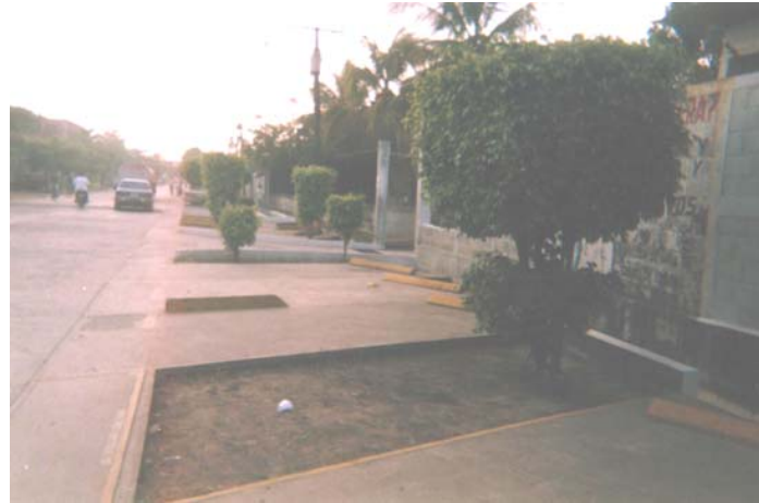
FOTO 1 Fachada Norte, que es la principal del Hospital en buen estado, calle pavimentadas en buen estado.
