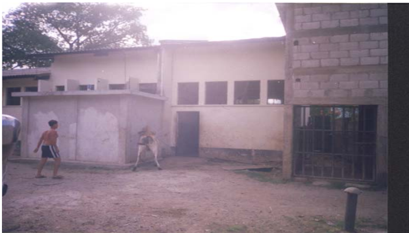
Instalaciones del rastro, vista desde el lado de el patio.
