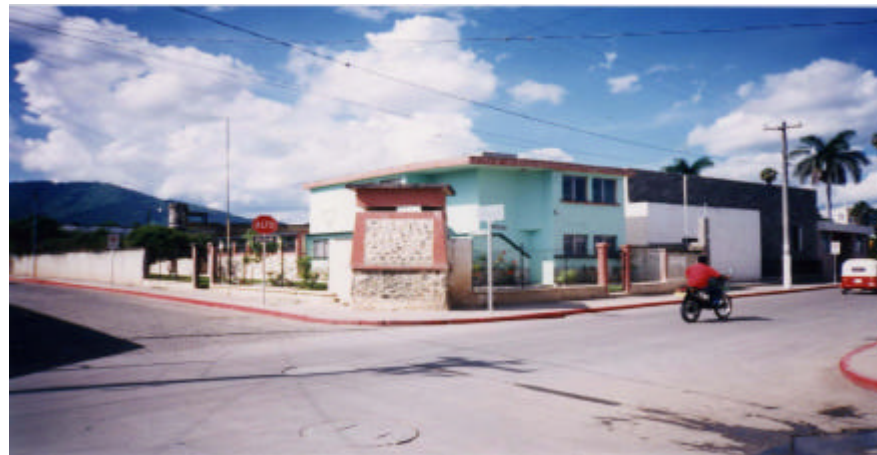
VISTA AL NORTE DEL EDIFICIO
