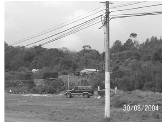
FOTOGRAFIA No. 10 Como se puede observar en la fotografía el terreno cuenta con el alumbrado público, telefonía.
