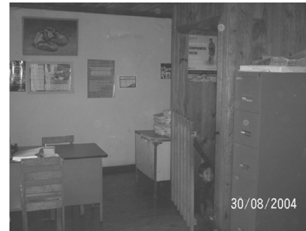
FOTOGRAFIA No. 07 Área de administración, el espacio reducido y no se cuenta con iluminación y ventilación adecuada.
