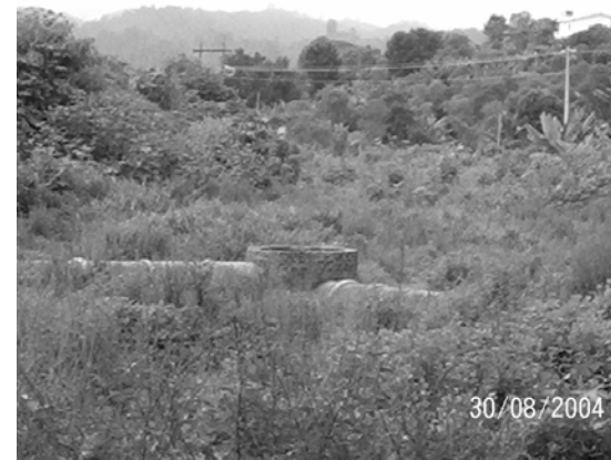
FOTOGRAFIA No. 11 En la parte este del terreno atraviesa la red de drenaje municipal.
