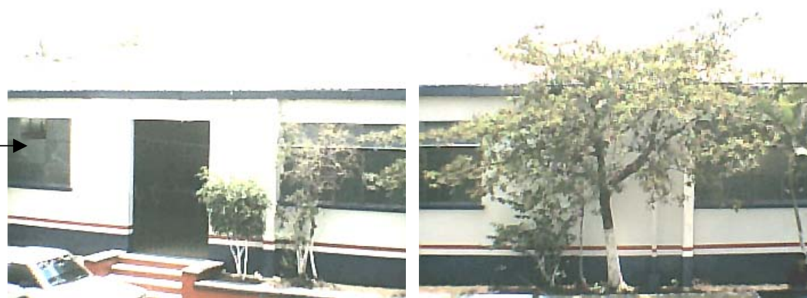
Foto 21: (Ver mapa vistas de fotografías, vista 3) Fachada frontal de la municipalidad, o edificio existente
