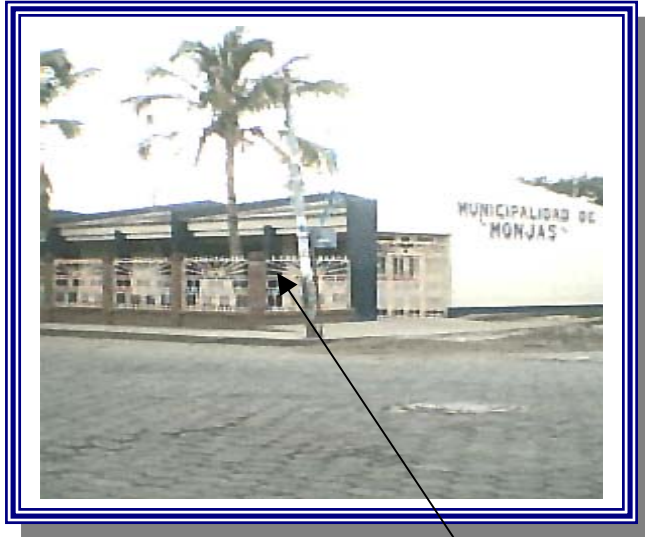
Fotografía 4 Esta es la fachada frontal, se observan los corredores.
