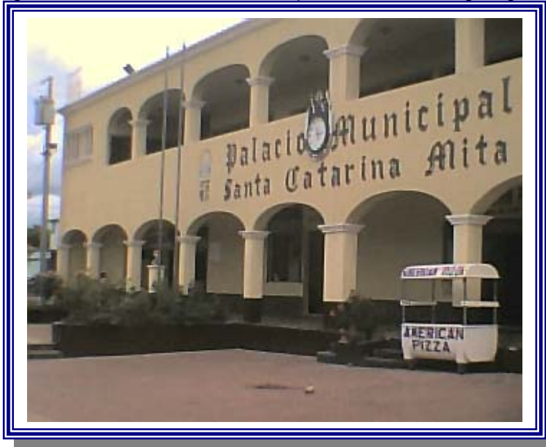
Se observa que existe una calle peatonal y un | Fotografía 11 ' Se ve la fachada ' rincipal del edificio.
