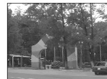
FOTOGRAFIA No. 1 VISTA ENTRADA
